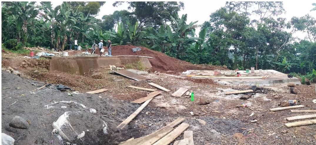
Fotografía 4. Tanque antiguo y tanque nuevo en construcción.
