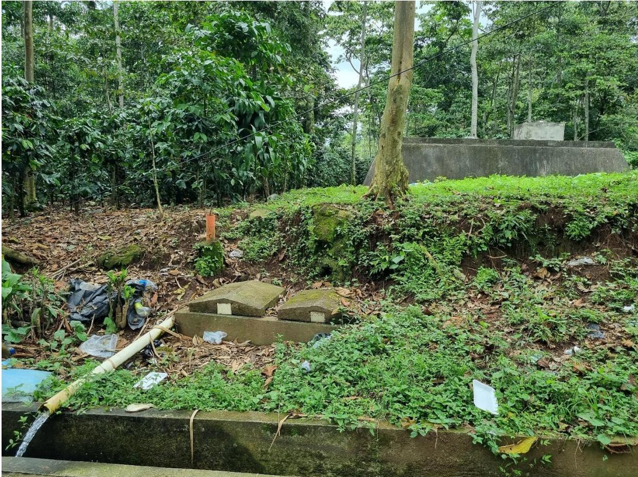
Fotografía 3. Terreno de tanque de distribución sin cerco perimetral, tubería expuesta vulnerable a rotura.
