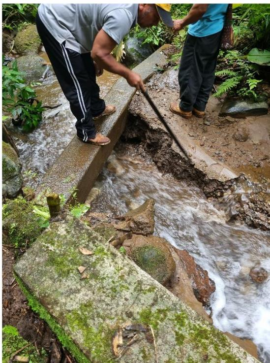
Fotografía 3. Rebalse tiene retorno de agua contaminada, riesgo de contaminación por inundaciones, tubería expuesta vulnerable a rotura.
