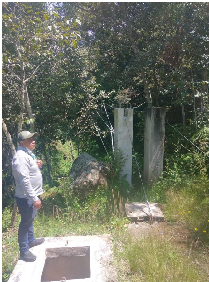
Figura 5 Paso aéreo del sistema
