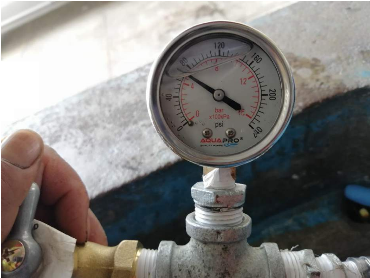
Fotografía 7 Medición de presión en Chorros
