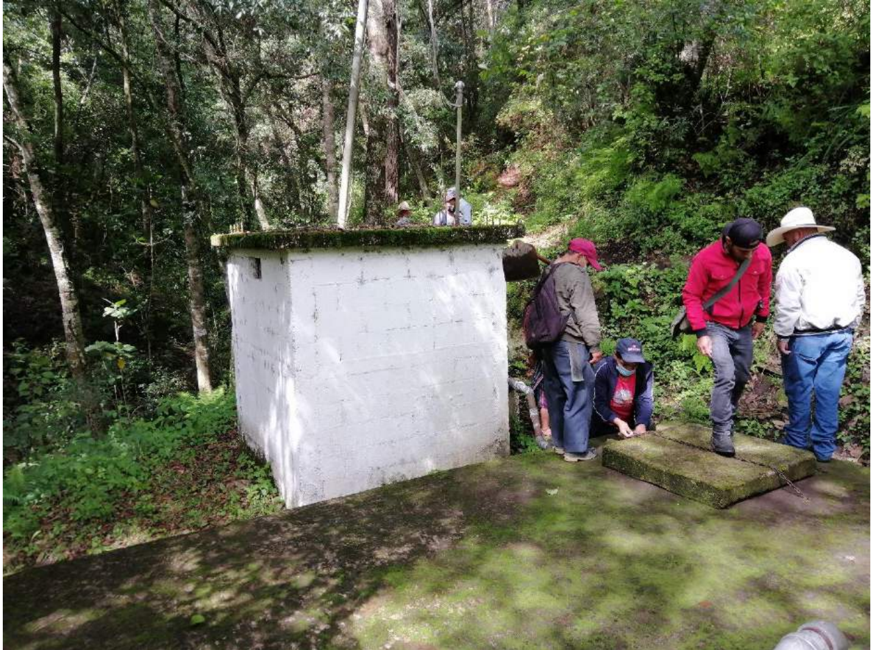
Fotografía 2 Tanque de succión del sistema primavera
