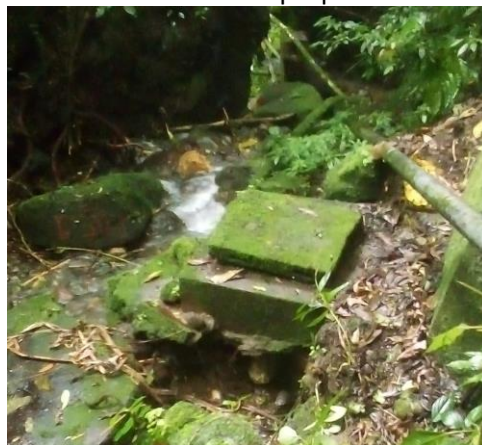
Fotografía 2. Riesgo de contaminación captación Rio Ixtacapa Elaboración propia.
