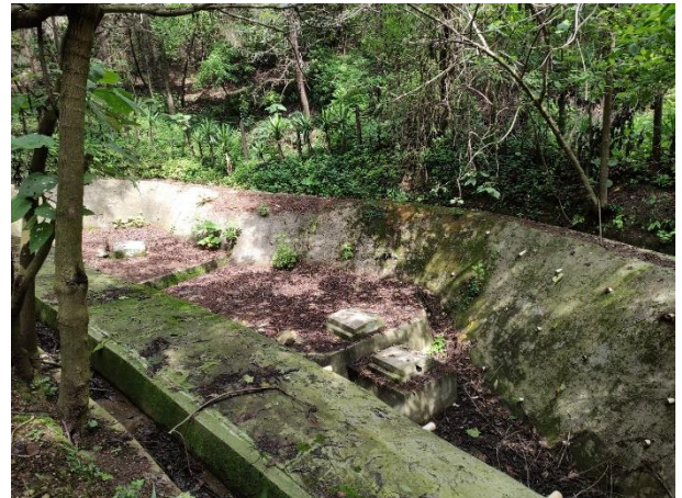
Ilustración 7: Fotografía de la captación No. 5
