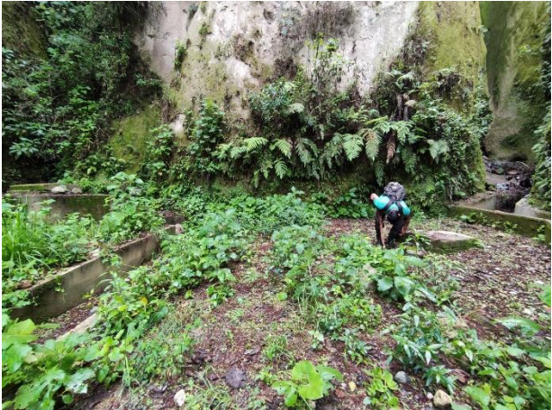
Ilustración 4: Fotografía de la captación No. 1 y 2
