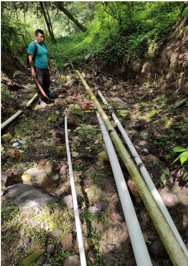
Ilustración 9: Fotografía del estado tubería de la captación
