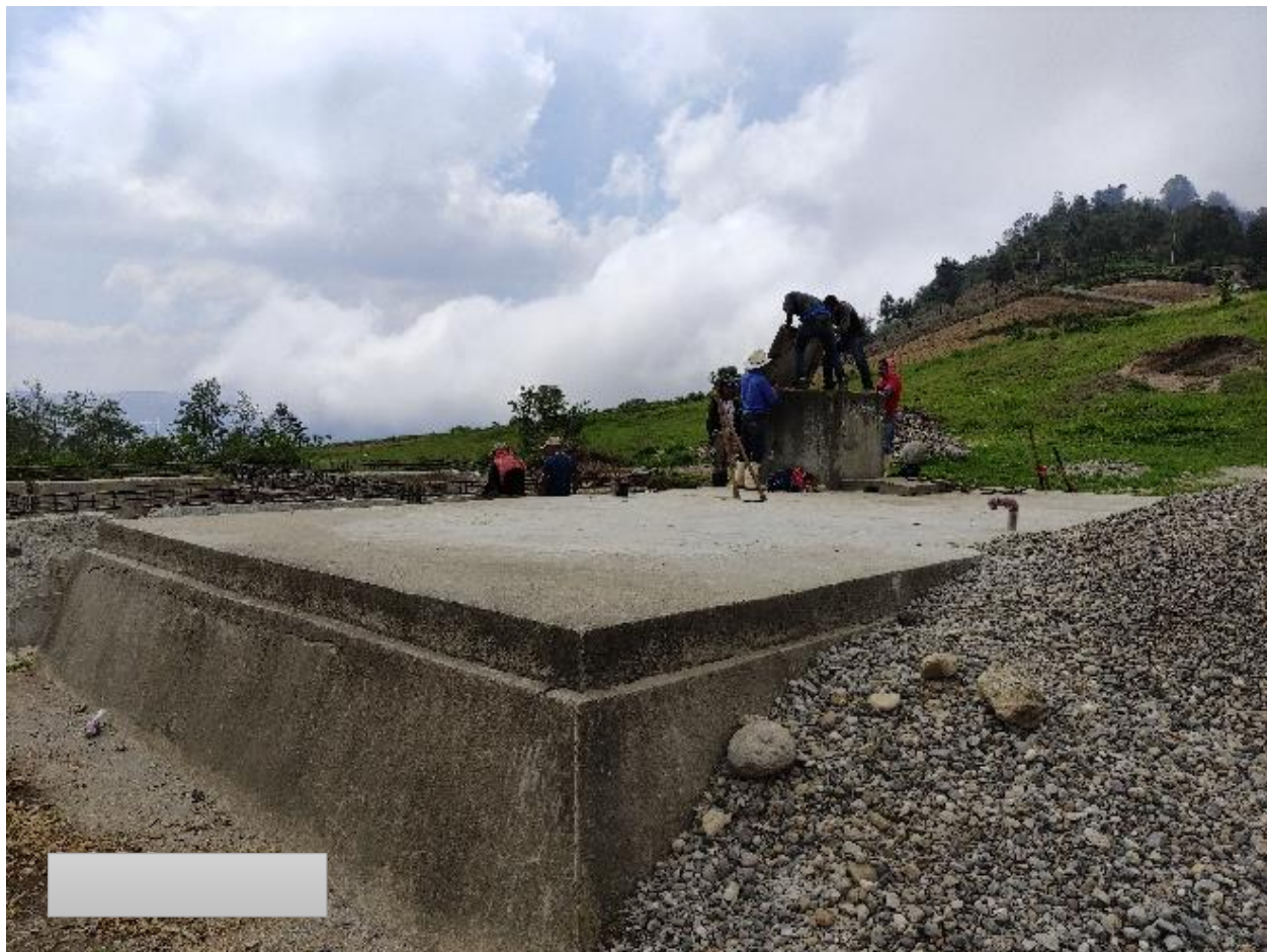
Ilustración 13: Fotografía del tanque de distribución
