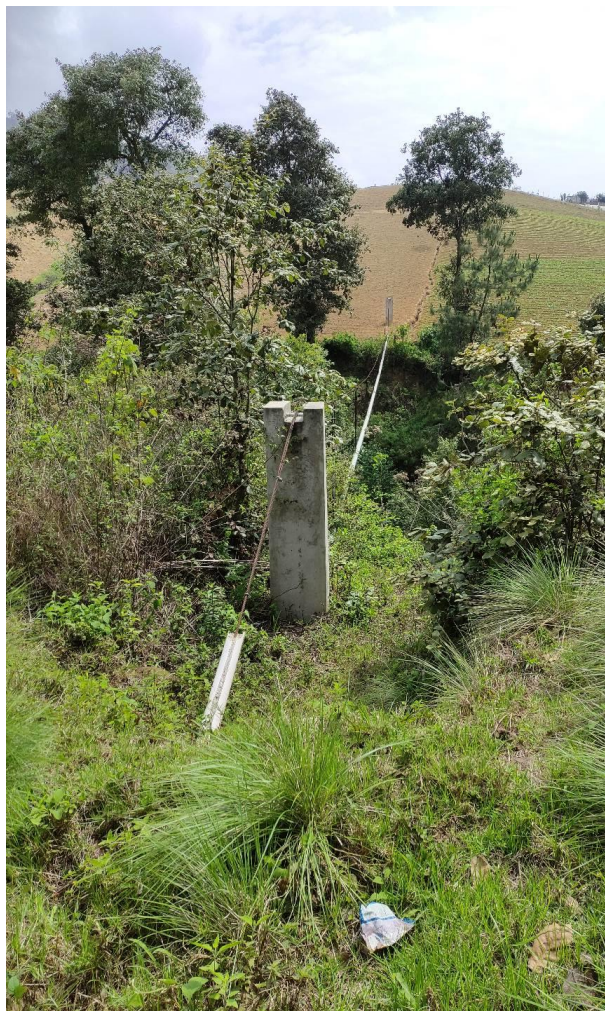
Ilustración 12: Fotografía del estado actual de uno de los pasos aéreos en la línea de conducción
