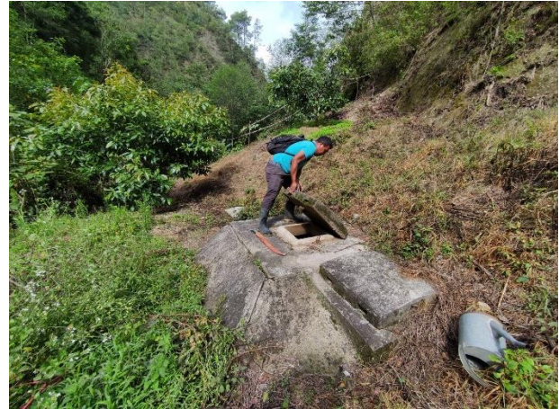
Ilustración 5: Fotografía de la captación No. 3
