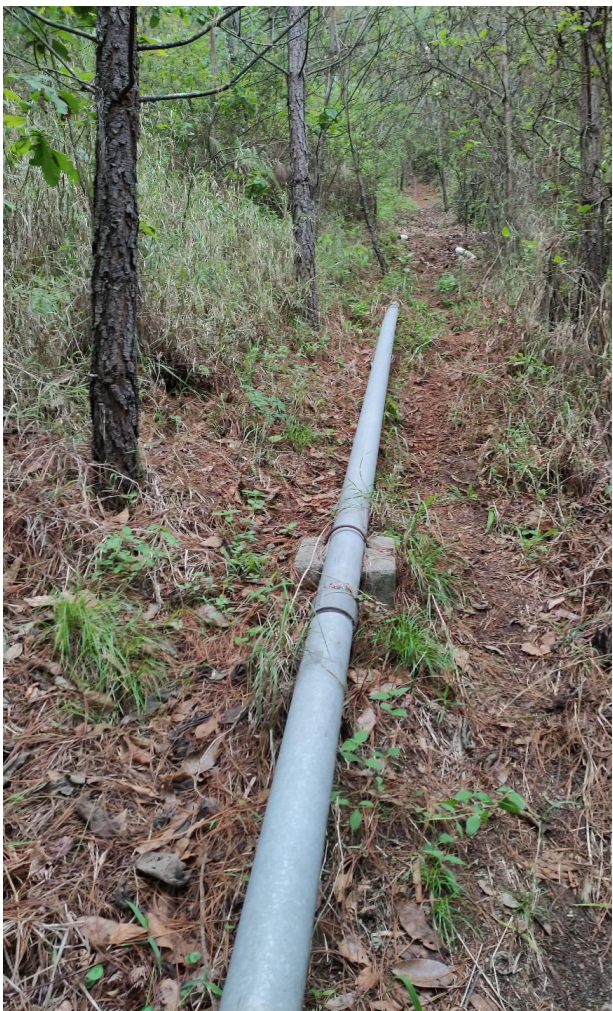
Ilustración 11: Fotografía del estado actual de la tubería HG en la línea de conducción
