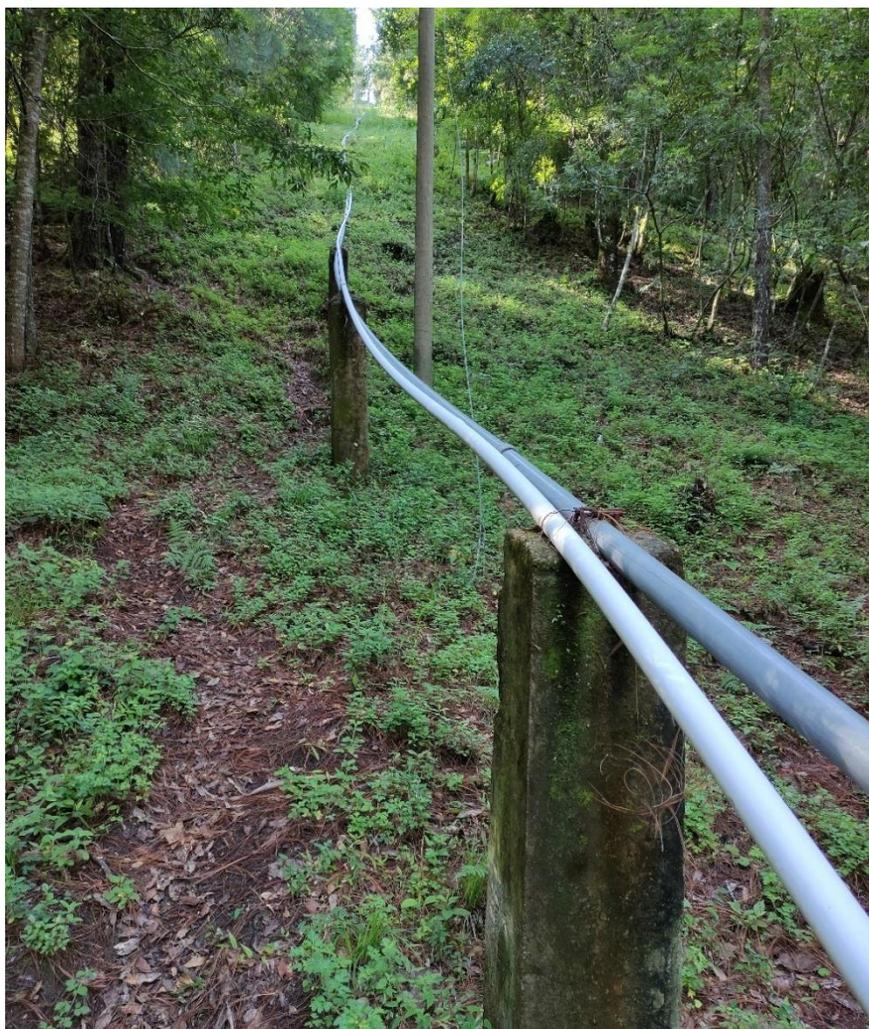
Ilustración 4: Fotografía de la línea de conducción tubería HG
