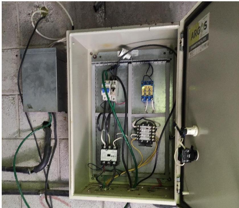
Ilustración 11: Fotografía del tablero de la bomba de agua
