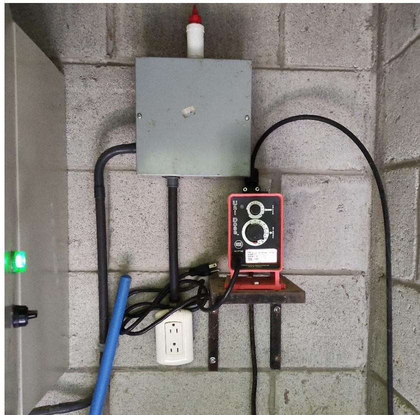
Ilustración 12: Fotografía de los componentes del sistema eléctrico de la bomba de agua
