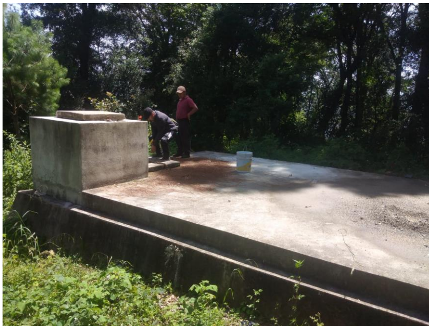
Figura 4 Tanque de distribución del sistema
