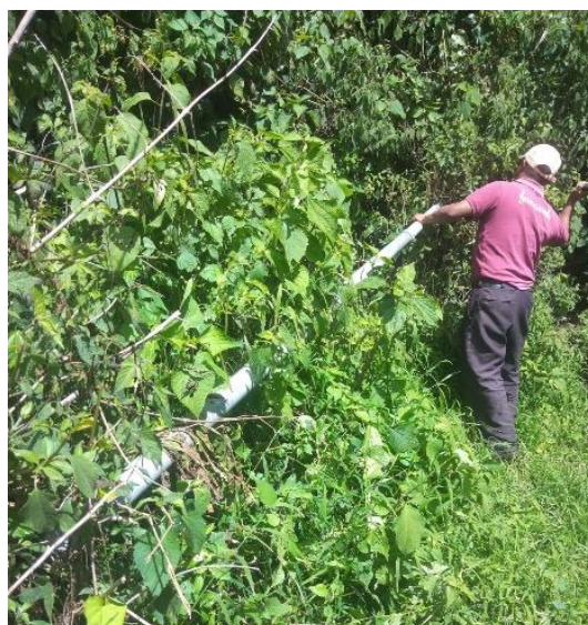
Figura 5 Paso aéreo del sistema
