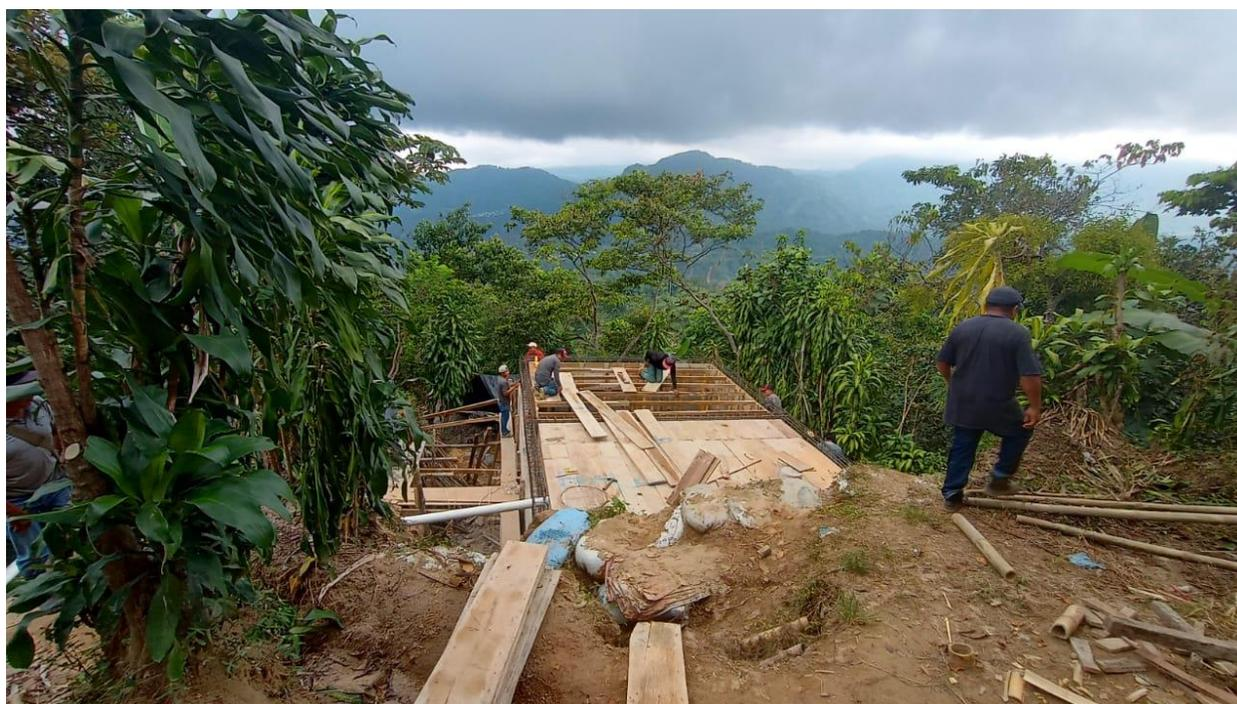
Fotografía 3. Tanque de distribución en fase constructiva, no se garantiza por parte de la comunidad la implementación de sistema de desinfección.
