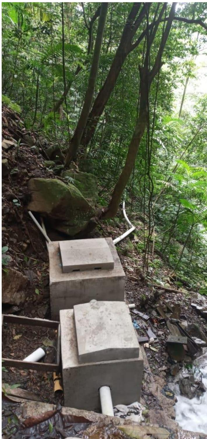
Fotografía 2. Tubería de salida de captación y de cajas reunidas de caudales expuestas en zona sensible a inundaciones, tubería expuesta.
