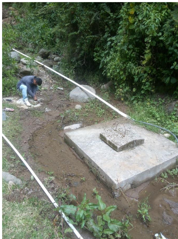
Fotografía 1. Caja reunidora de caudales y tubería que no está enterrada
