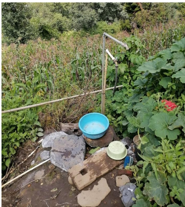
Fotografía 8. Conexión domiciliar sin pila
