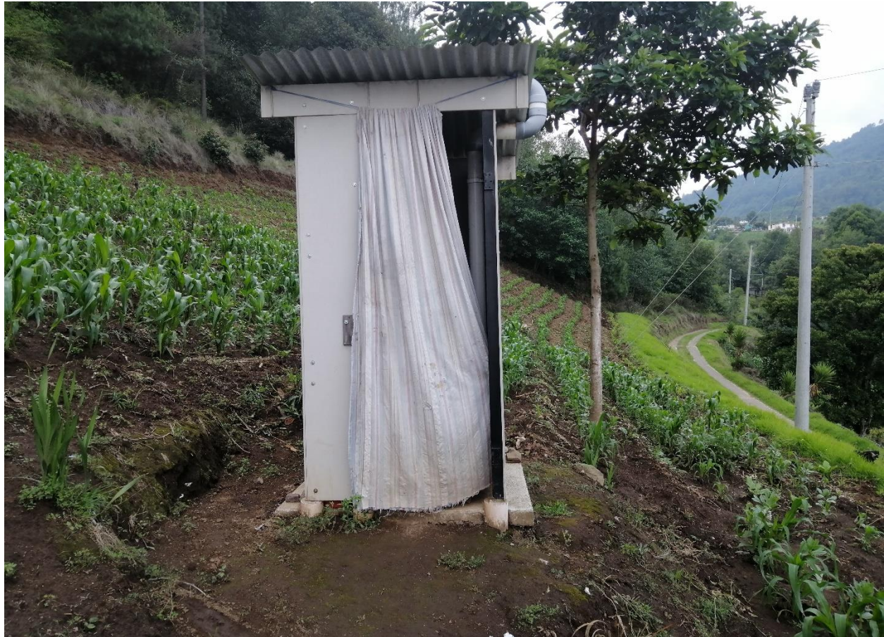
Fotografía 6 Letrina de hoyo seco ventilado, ubicados en la comunidad de Chirij Cruz
