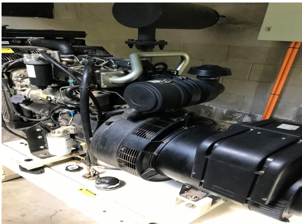
Ilustración 11. Unidad de bombeo
