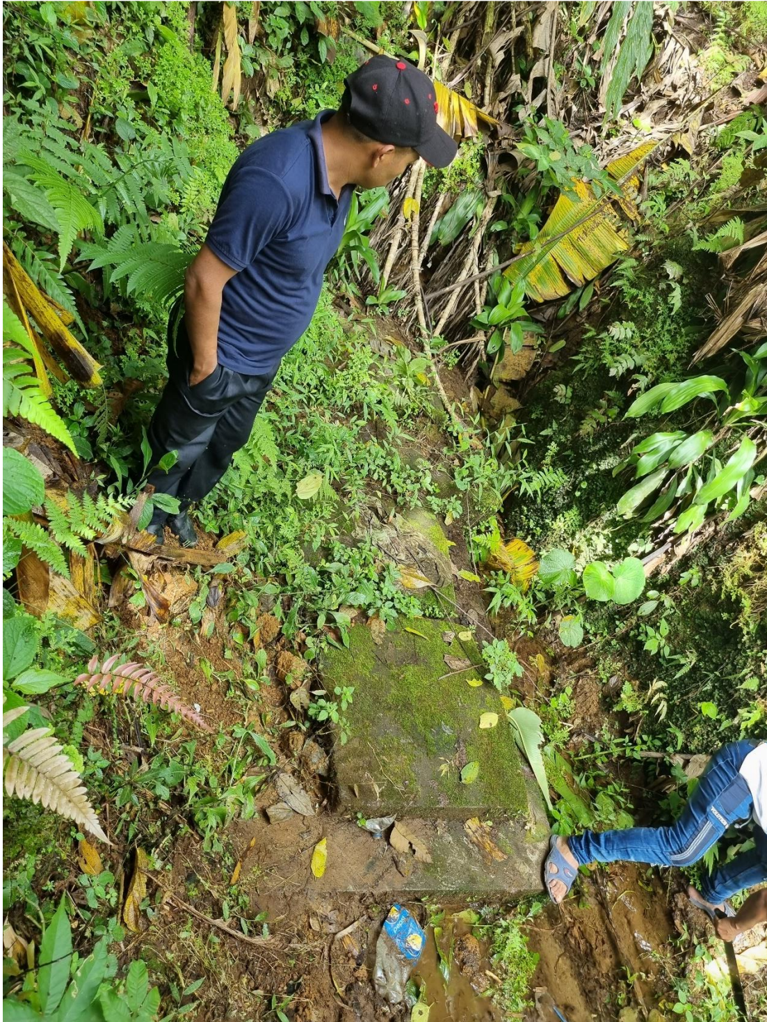
Fotografía 2. Deficiencias en frecuencia de limpieza.
