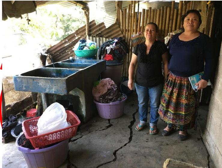
Ilustración 10: Fotografía de pila y desfogue de aguas grises a flor de tierra.
