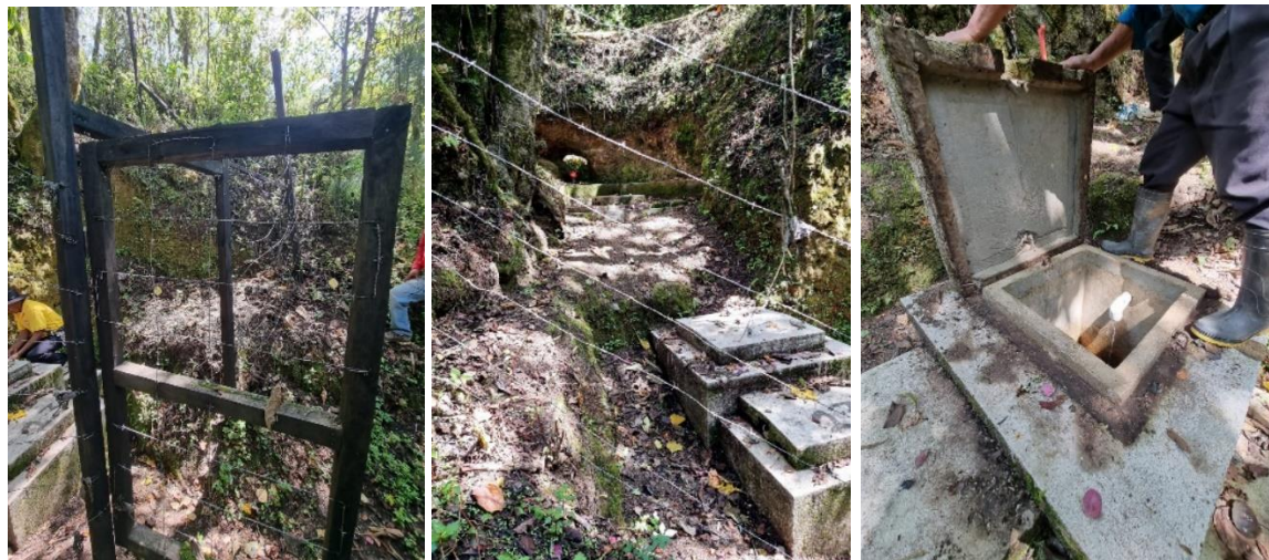
Fuente: Visita técnica 12/05/2021
