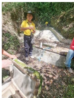
Fuente: Visita técnica 12/05/2021
