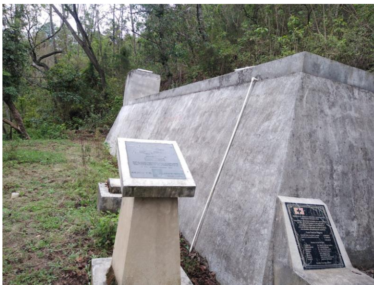
Fotografía 3 Vista del tanque de almacenamiento
