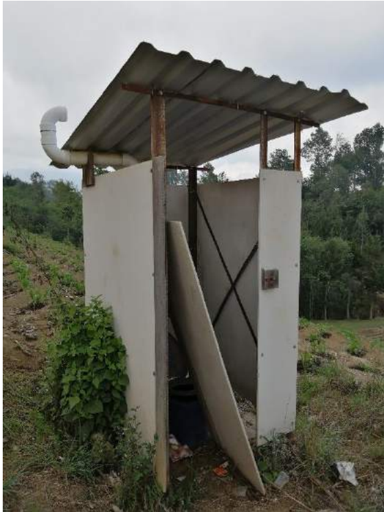
Fotografía 12 Mejora a implementar. Limpieza, chapeo y destronque en letrinas. Clorador en estado averiado, implementar clorador artesanal.
