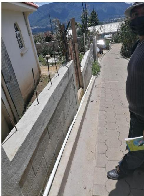
Fotografía 7. Tubería de la red de distribución expuesta
