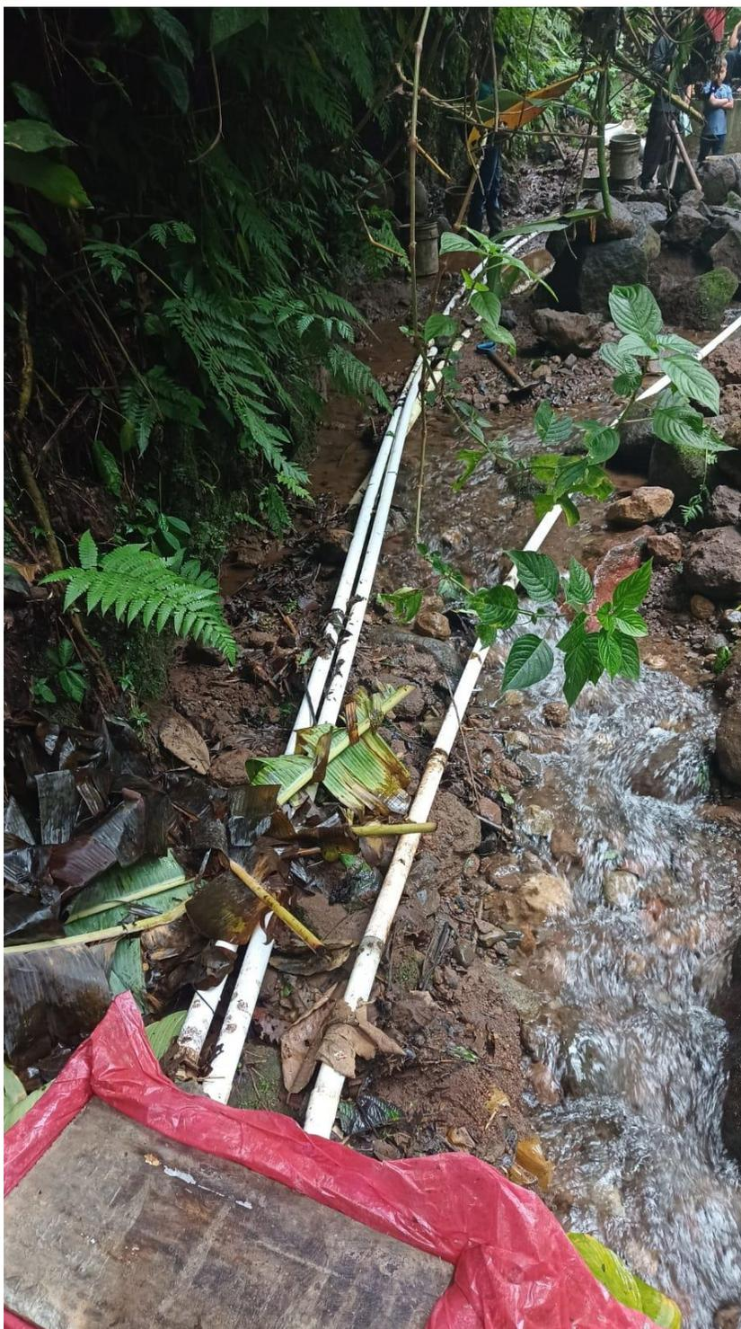
Fotografía 3. tubería expuesta vulnerable a rotura.
