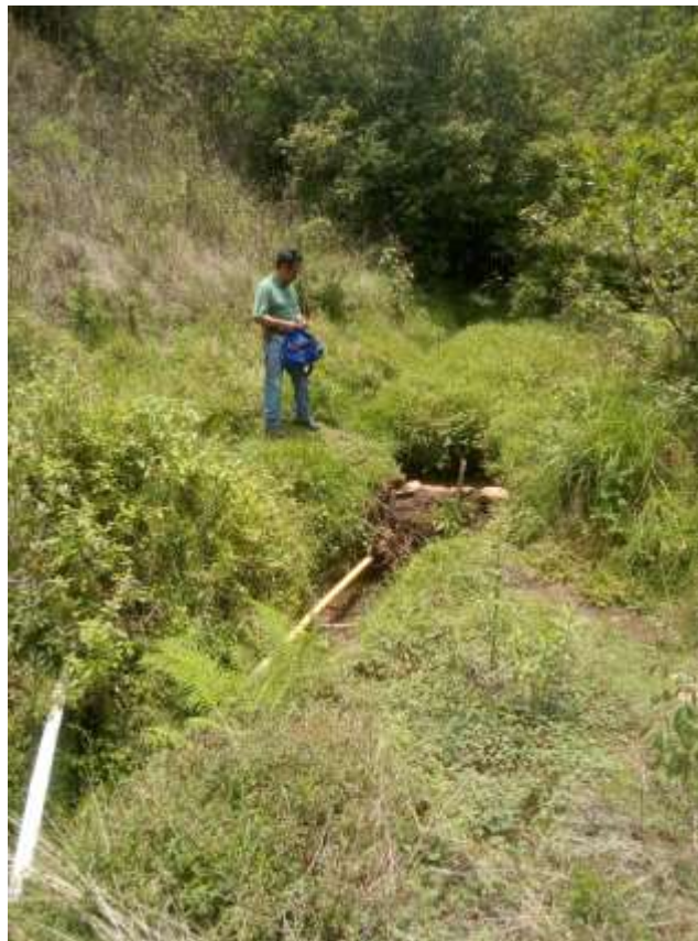
Fotografía 4. Tubería existente Elaboración propia.
