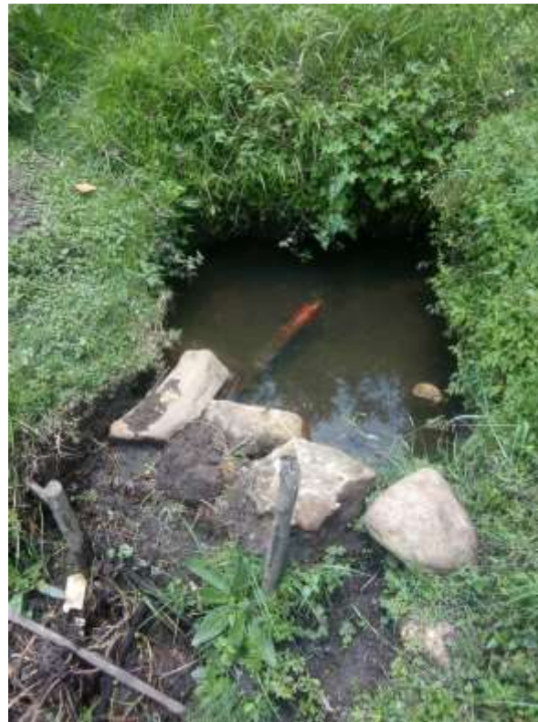
Fotografía 1. Actual captación Elaboración propia.
