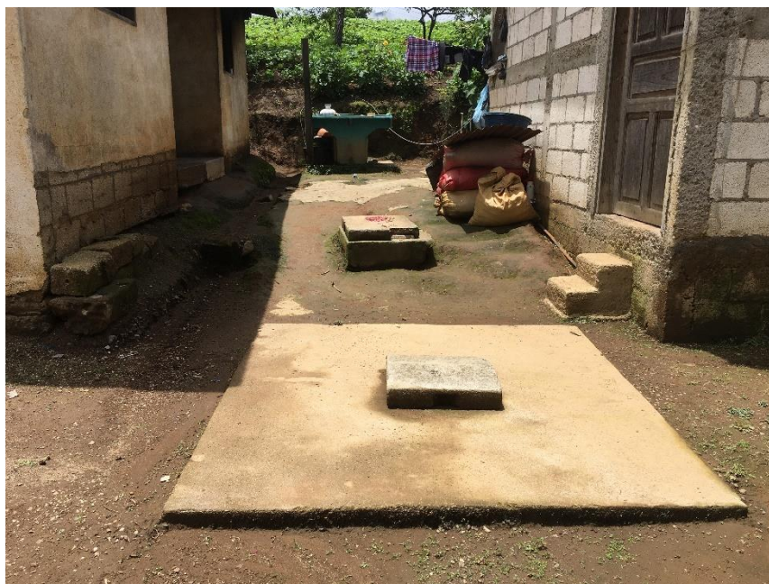
Ilustración 7: Fotografía de caja en línea de distribución
