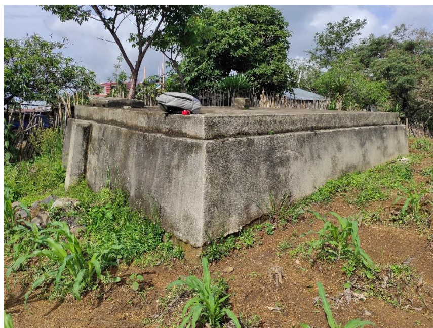
Ilustración 6: Fotografía de riesgo inexistencia sistema de almacenamiento
