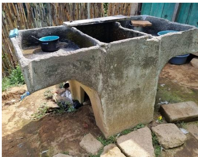
Fotografía 19. Disposición de aguas grises a flor de tierra.
