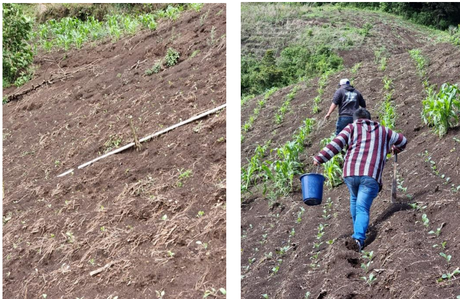
Fotografía 6. Tubería expuesta de línea de conducción.
