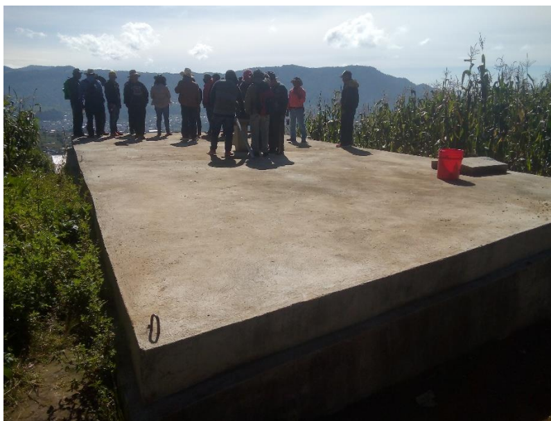
Fotografía 3. Tanque de distribución Sistema Sarruch
