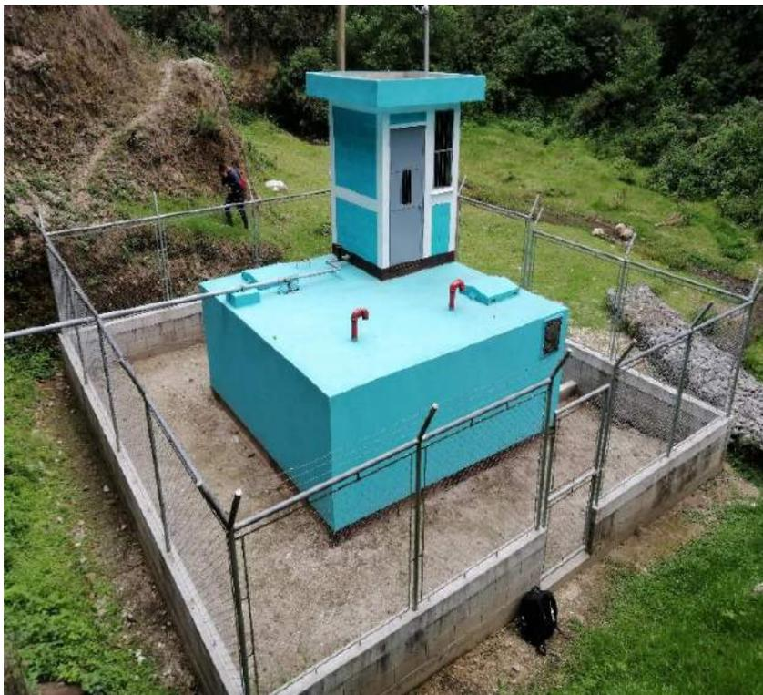
Fotografía 10 Tanque de succión y caseta de bombeo
