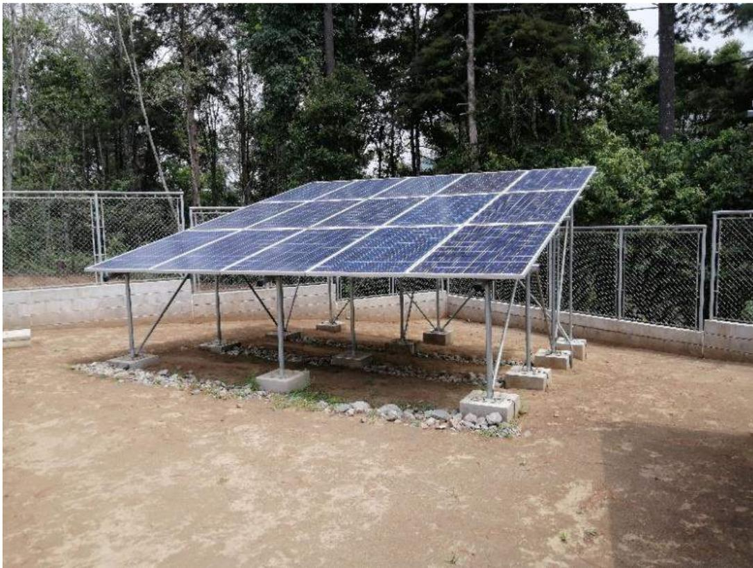
Fotografía 9 Paneles solares del sistema de agua de Valle Nuevo
