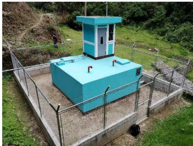
Fotografía 3 Tanque de succión del sistema de agua de Valle Nuevo
