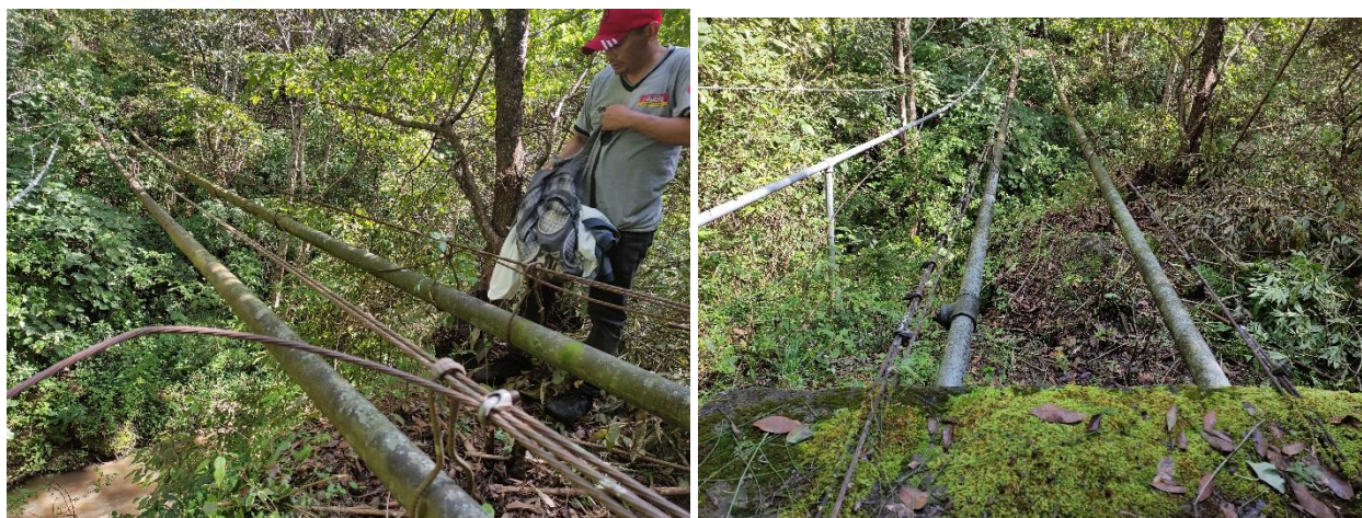
Ilustración 6: Fotografía del último paso aéreo en buenas condiciones
