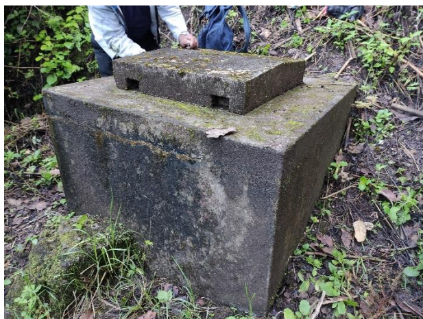
Ilustración 4: Fotografía de la caja rompe presión
