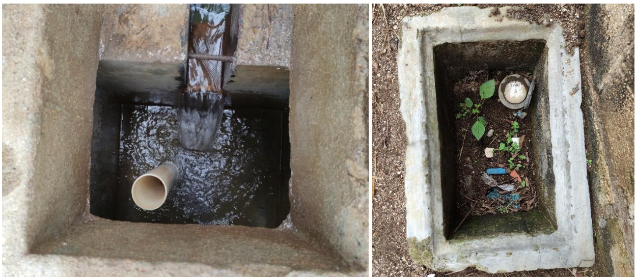
Ilustración 9: Fotografías del vertedero en la caja distribuidora de caudales y contador dentro la red de distribución
