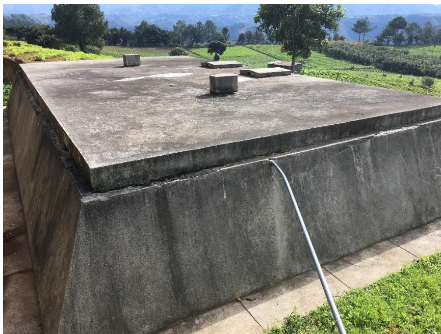
Ilustración 9: Fotografía del tanque de distribución del Chuisajcap.
