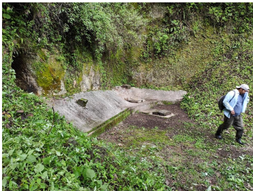
Ilustración 6: Fotografía de riesgo en la captación 3.
