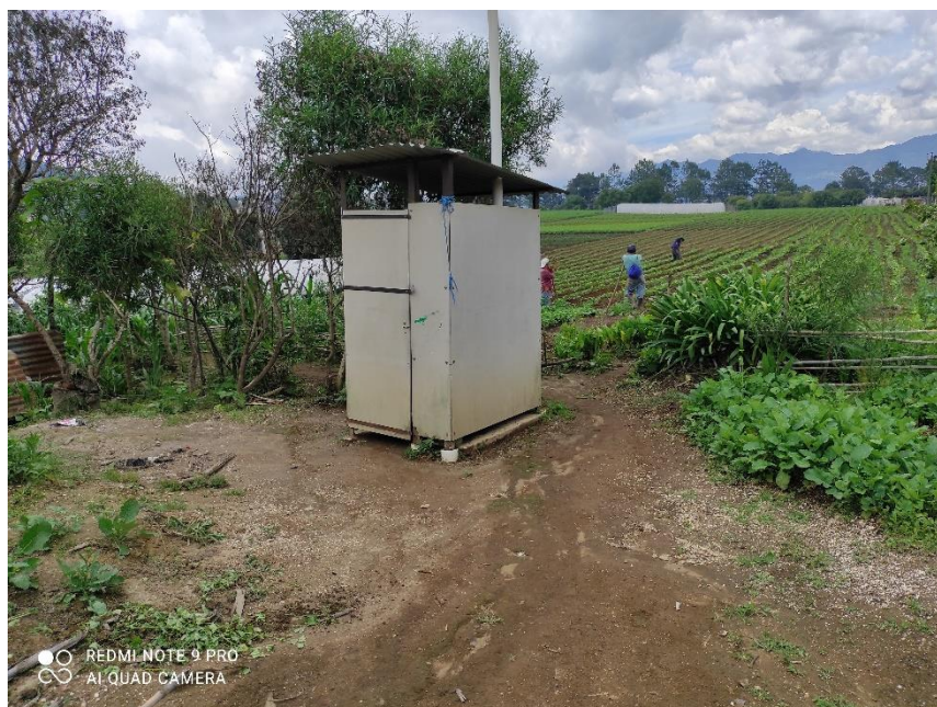
Ilustración 12: Fotografía de letrina de hoyo seco ventilado y su estado.
