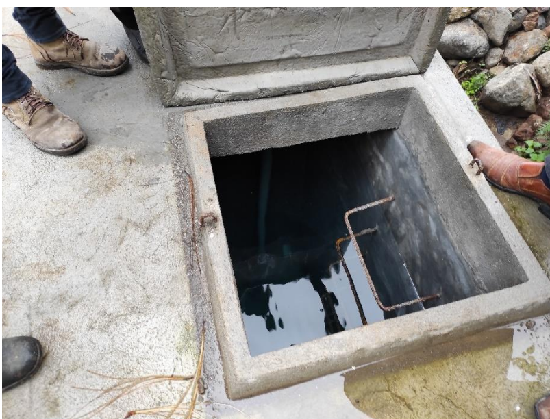
Fotografía 6 interior tanque de almacenamiento/distribución
