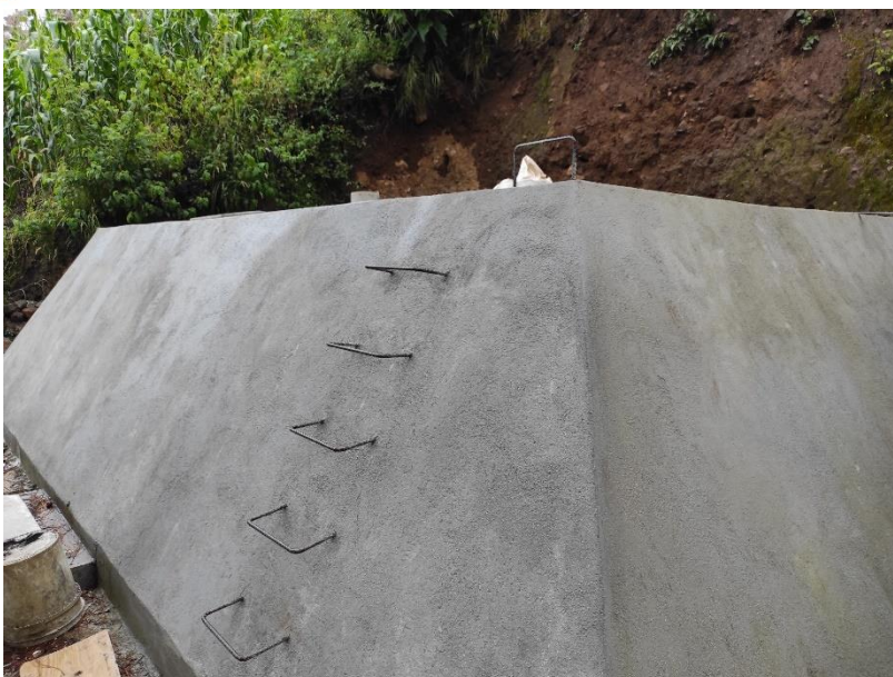
Fotografía 5 de tanque de almacenamiento.
