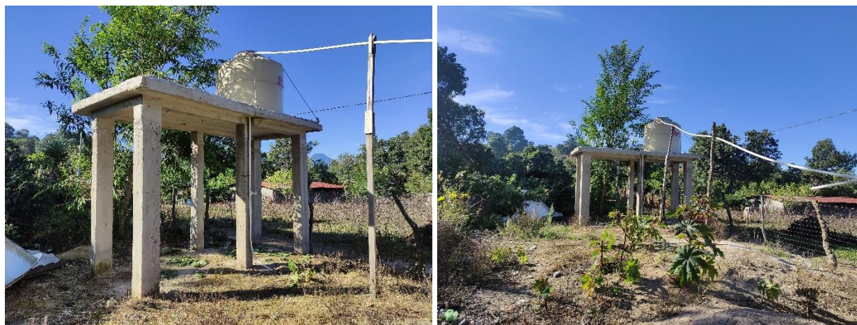
Ilustración 4: Fotografías del depósito de agua
