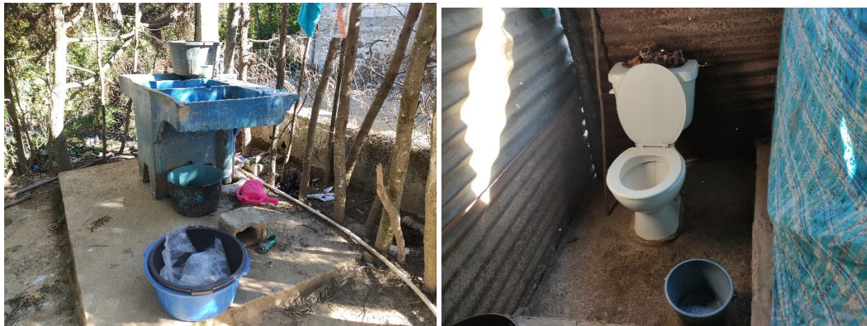
Ilustración 5: Fotografías del estado del saneamiento
