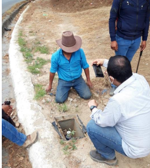
Fotografía 4 Caja válvula de aire San José Xiquinabaj
