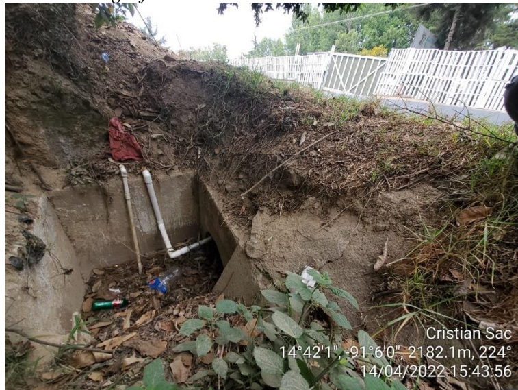
Fotografía 5 Paso de tubería de conducción
