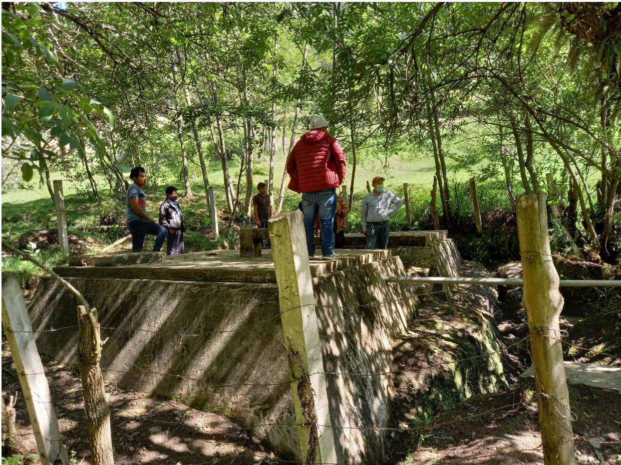
Fotografía 3. No existe espacio físico para sistema de desinfección en ninguno de los dos tanques.
