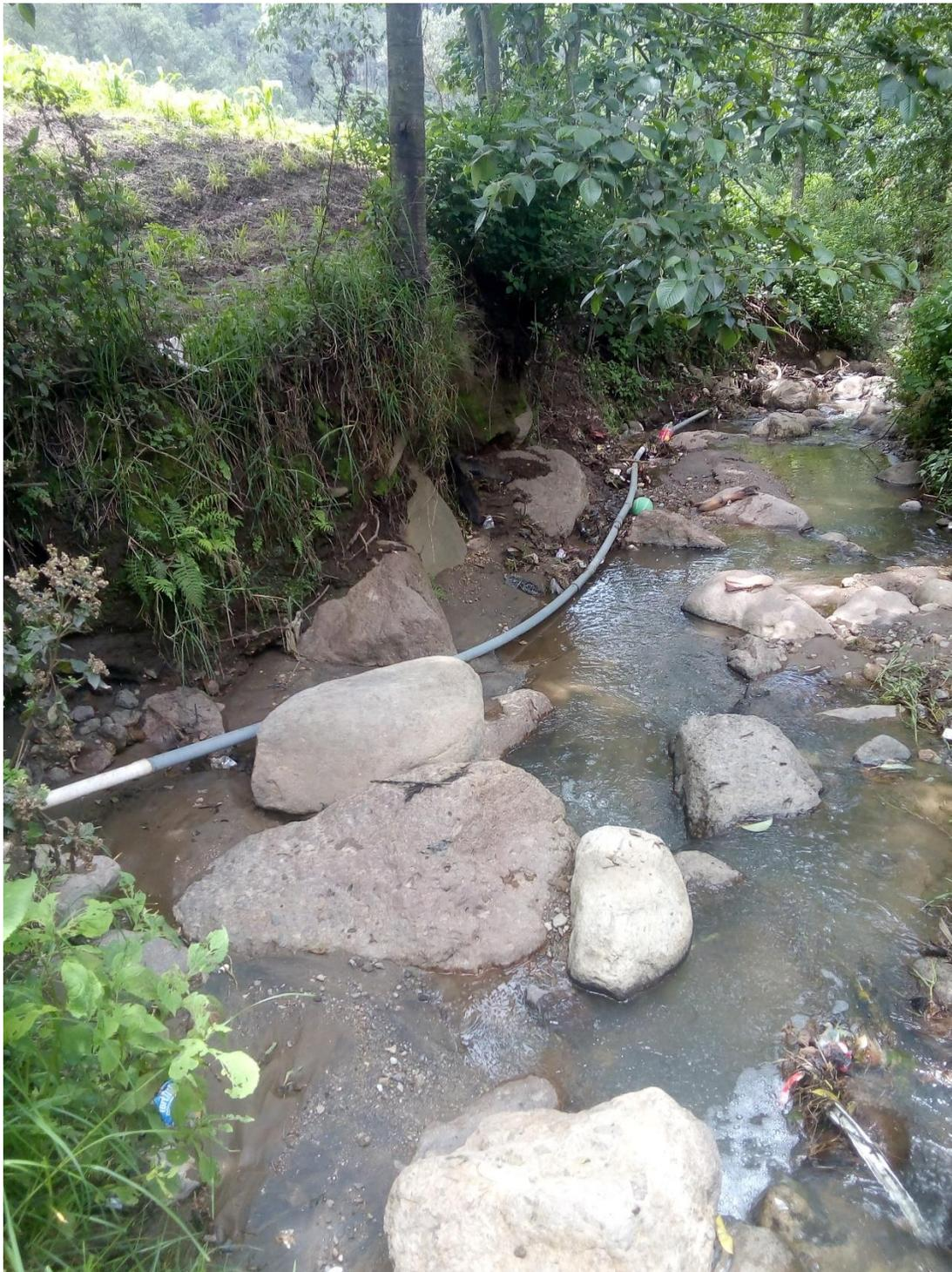
Fotografía 3. Tubería expuesta en todo el tramo de conducción.
