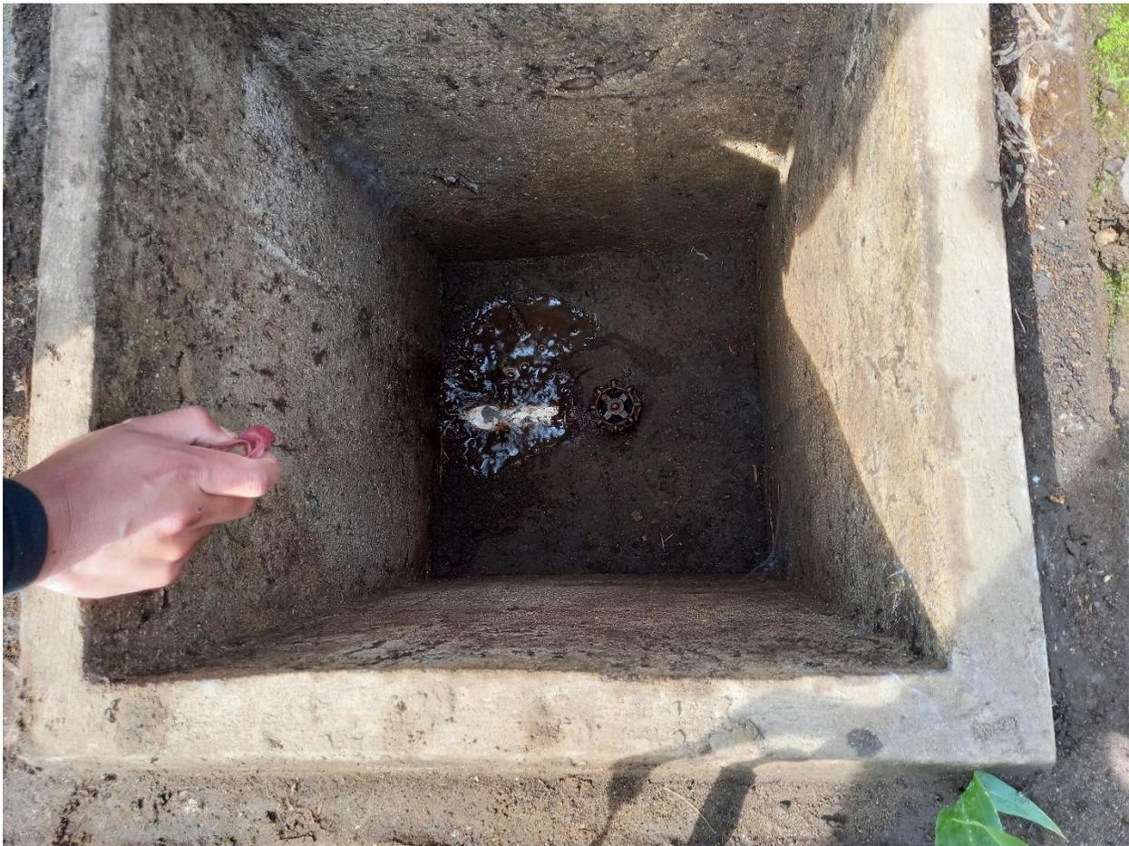
Fotografía 5. Fugas en todo el sistema de distribución.
