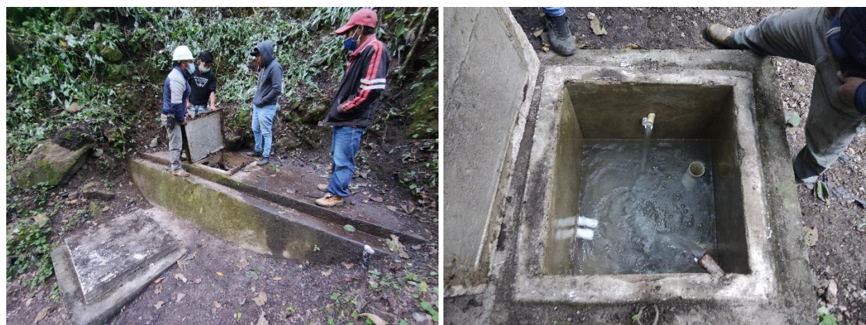
Ilustración 3: Fotografías del nacimiento uno y caja reunidora de caudales
