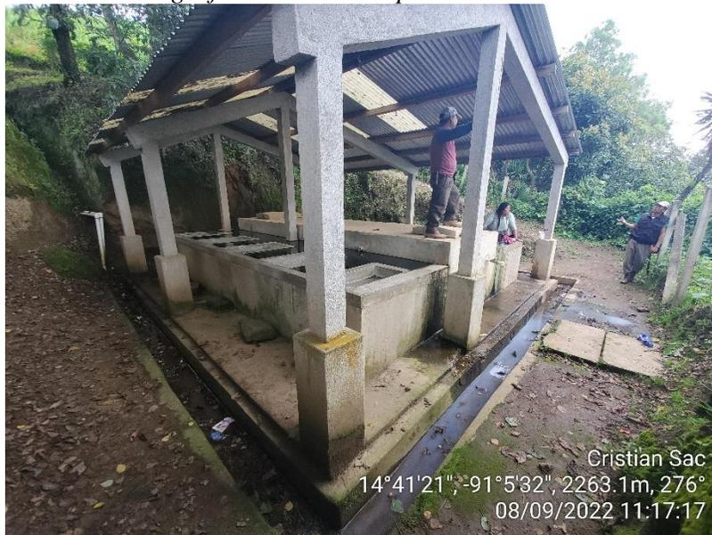
La estructura de las pilas es por medio de pilares y vigas de concreto armado, lavaderos de concreto y techo de lámina, los tendales secundarios del techo se están hechos de madera, la estructura en general se encuentra en buenas condiciones, no se observa un deterioro significativo, las pilas son conservadas por toda la población del caserío, ellos apoyan en distintas actividades para la conservación.
