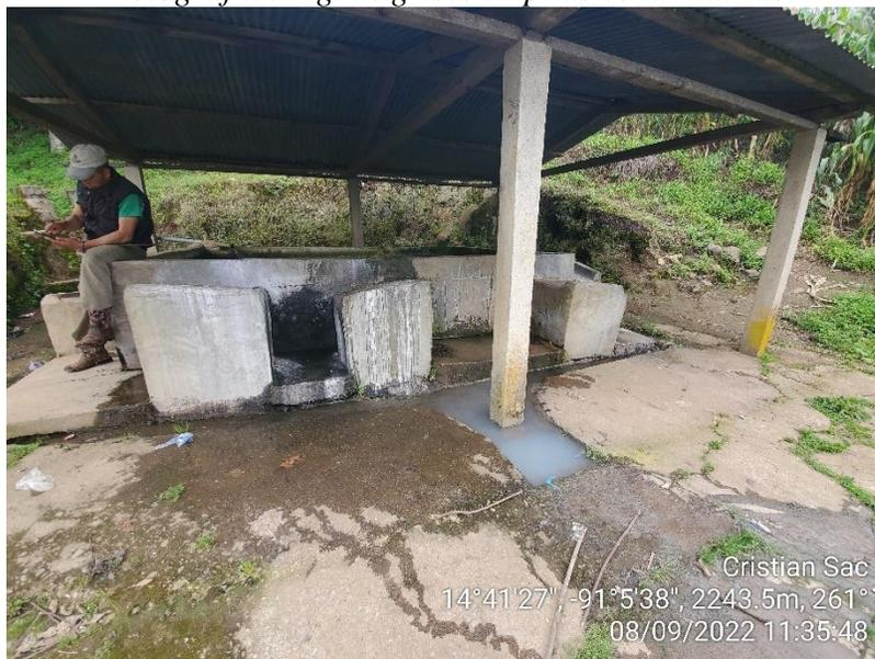
La fotografía anterior nos muestra el desfogue de las aguas grises de la pila privada, esta se encuentra acumulada en uno de los pilares, para posteriormente desfogarse a flor de tierra, la estructura se encuentra deteriorada. Los miembros del COCODE indicaron que tienen la intención de realizar alguna actividad para realizar reparaciones y mejorar su condición, sin embargo, no cuentan con los recursos para realizar esta actividad.
