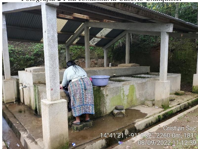
En la Fotografía 2 Pila comunitaria Caserío Chuiquistel podemos observar que la pila cuenta con un tanque de almacenamiento el cual tiene dimensiones de 1.68x5.70x1.00 mt<sup>3</sup> que la población utiliza para suministrarse del vital líquido, sin embargo, este tanque abastece a las pilas de agua por medio del rebalse de tubos lo que en general hace que el volumen almacenado dentro del tanque no tenga ningún movimiento.
