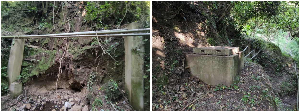
Ilustración 7: Fotografías del paso de zanjón y la caja de concreto + la válvula de aire
