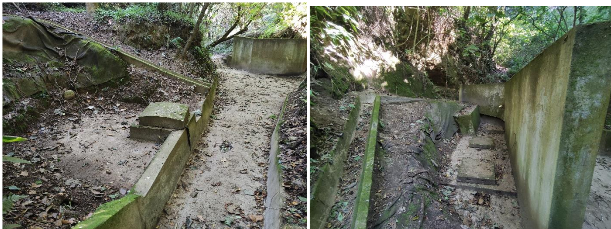
Ilustración 3: Fotografías de las captaciones en los nacimientos uno y dos
