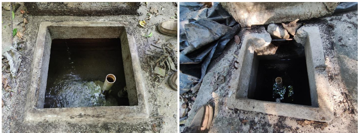
Ilustración 6: Fotografías de las cajas reunidoras de caudales
