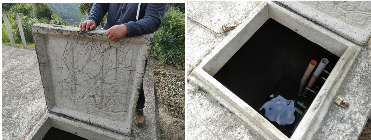
Ilustración 11: Fotografías de la tapadera de la cámara del tanque de distribución
