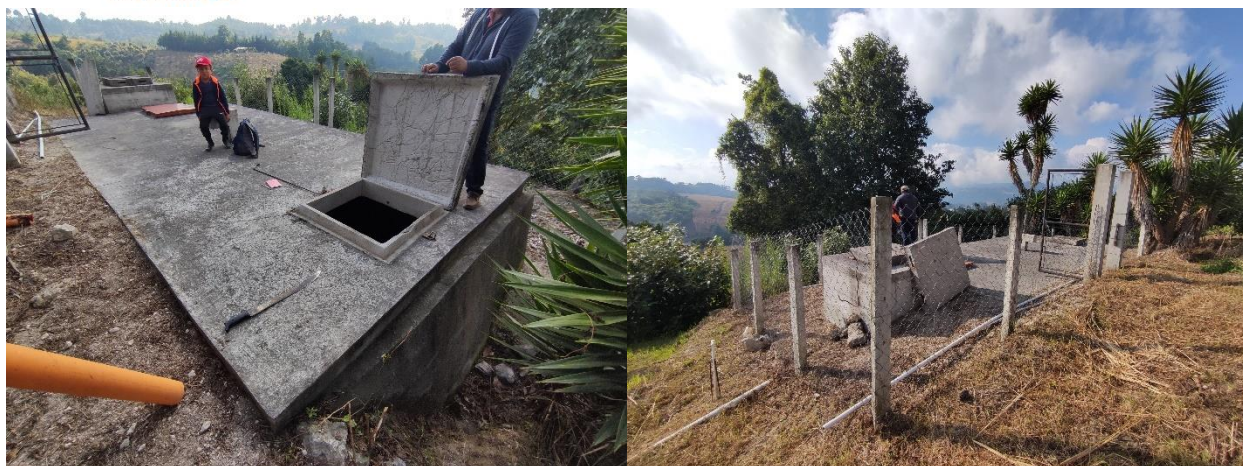
Ilustración 10: Fotografías del tanque de distribución
