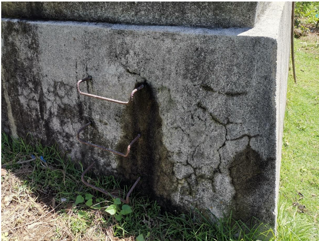
Fotografía 4: Vista del tanque de distribución
