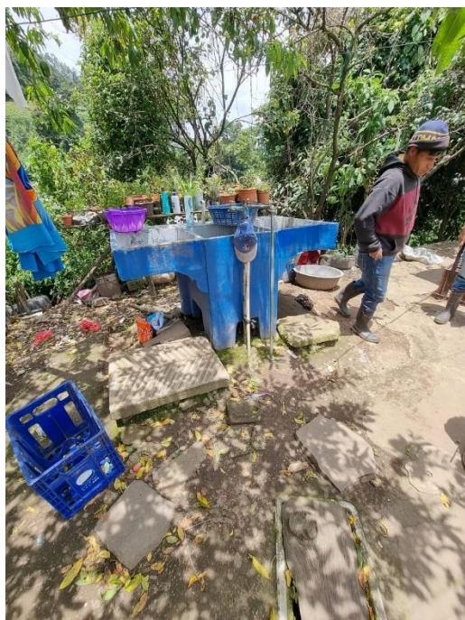
Fotografía 18. Disposición de aguas grises a flor de tierra.
