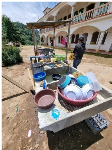
Fotografía 16. Disposición de aguas grises a flor de tierra.
