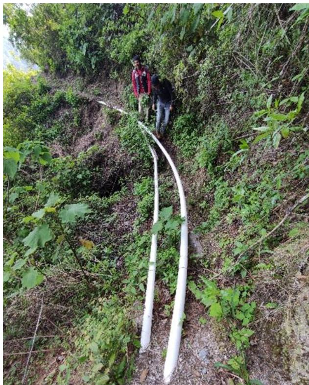
Ilustración 5: Fotografía de tubería vulnerable en la línea de conducción
