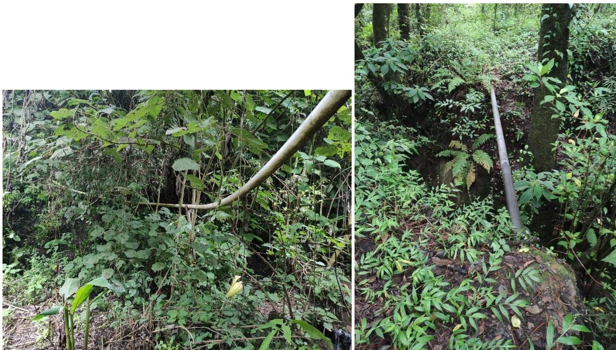
Ilustración 6: Fotografías de tubería vulnerable en la red de distribución y un paso de zanjón
