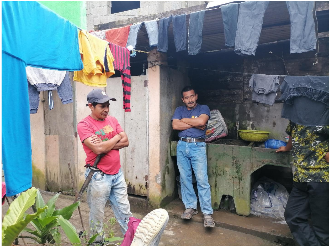
Fotografía 8. Conexiones domiciliarias con drenaje que no va a PTAR.
