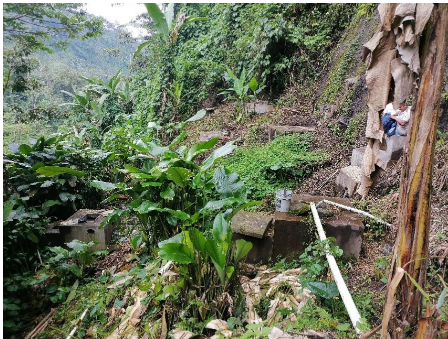
Fotografía 1. Todas las captaciones y cajas reunidoras de caudales sin cerco.
