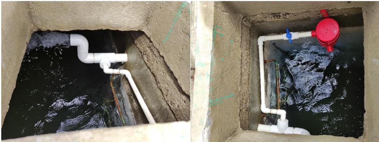
Ilustración 7: Fotografía del termo de clorador, instalado en el tanque de distribución
