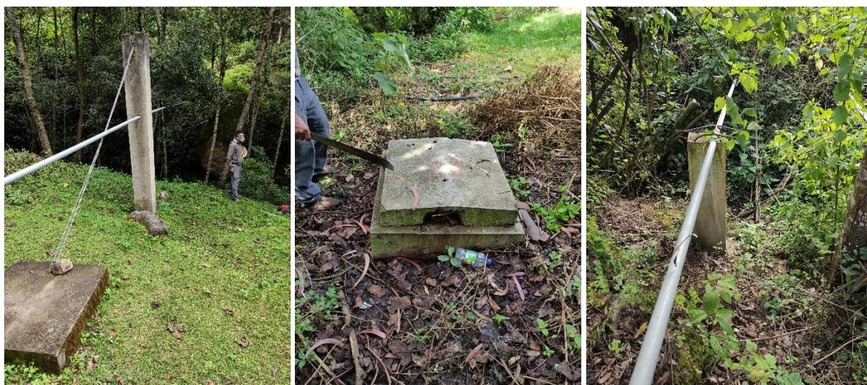
Ilustración 5: Fotografía de paso aéreo, caja con válvula de limpieza y paso de zanjón, en excelentes condiciones
