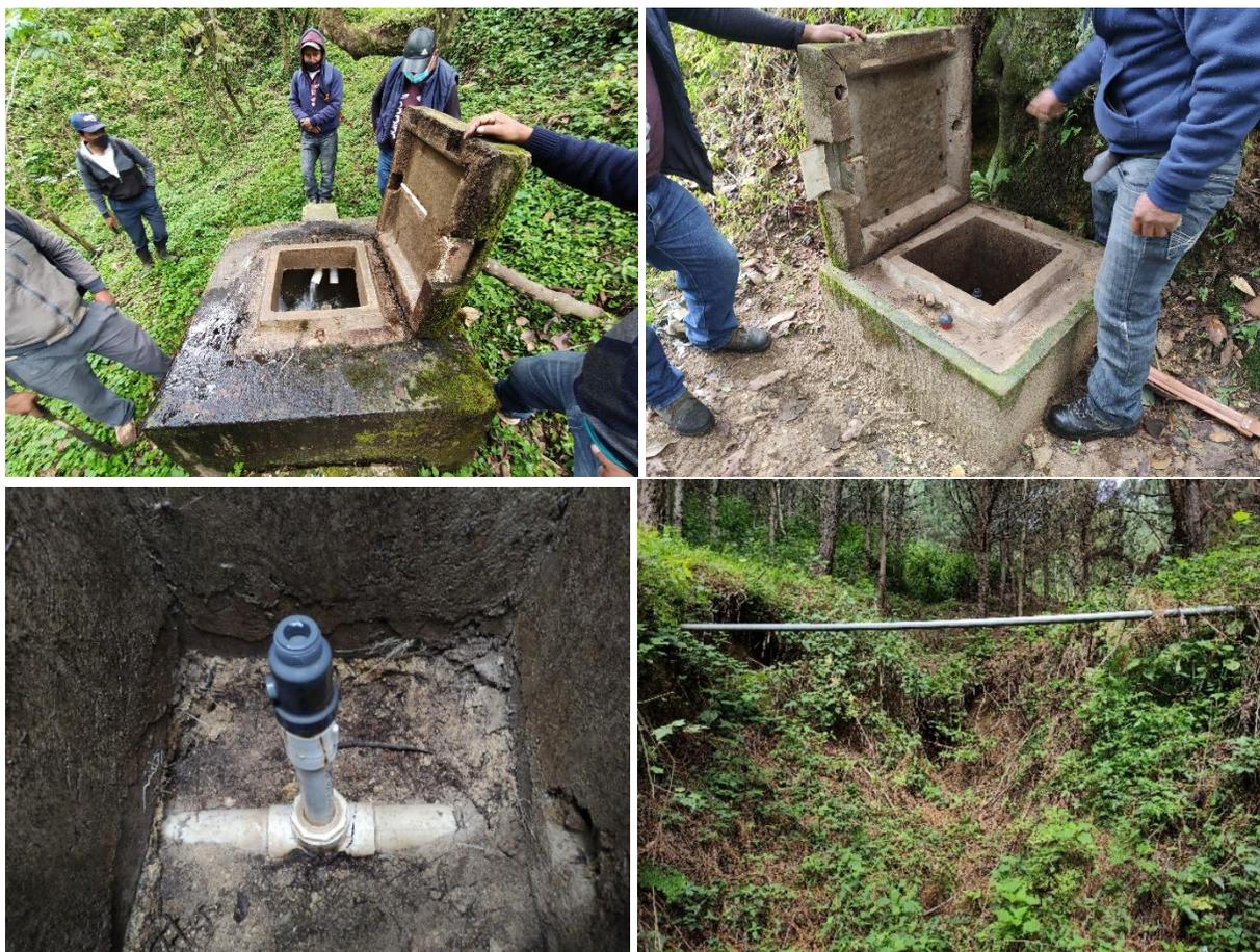
Ilustración 6: Fotografías de la caja reunidora de caudales, caja de concreto + válvula de aire y paso de zanjón (solo tubería)
