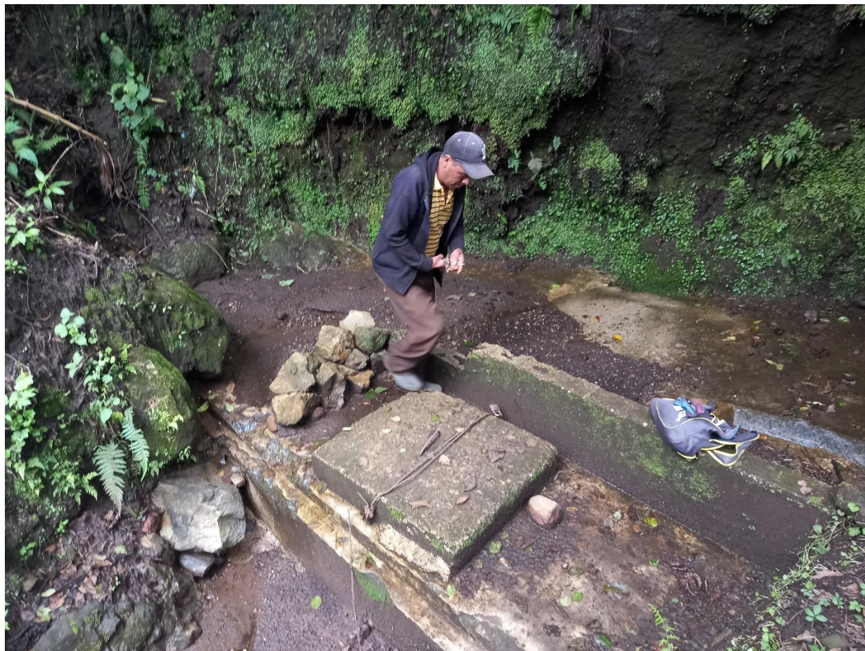
Fotografía 2. Captación con riesgo de inundación. Elaboración propia.
