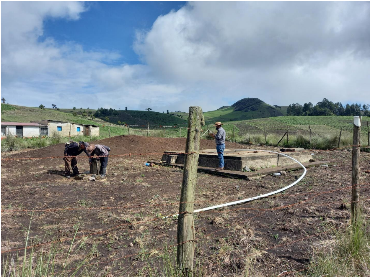
Fotografía 3 y 4. No existe espacio físico para sistema de desinfección en ninguno de los tanques. Elaboración propia.
