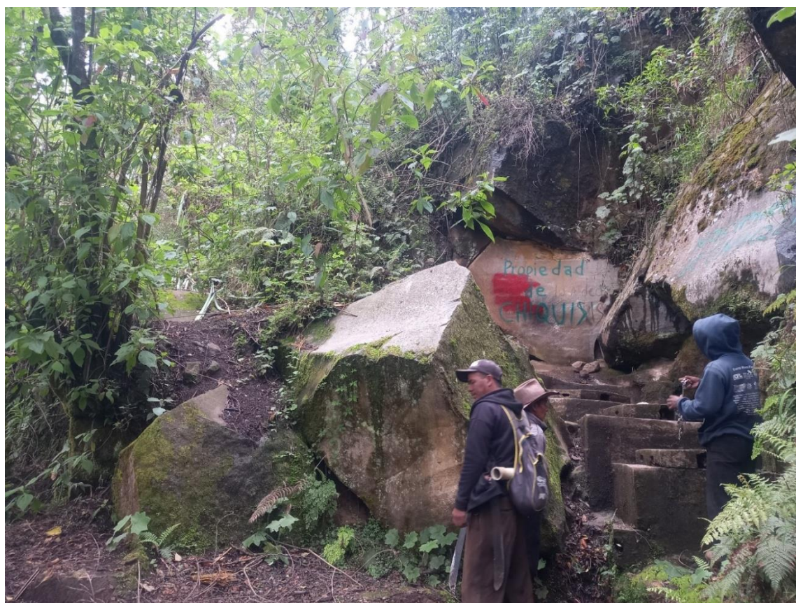
Fotografía 1. Captación 1 sin cerco perimetral. Elaboración propia.
