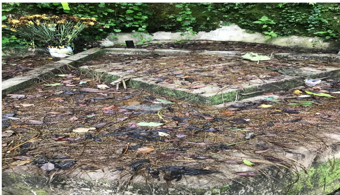
Ilustración 3. Obra de arte para la captación de la fuente, requiere realizar limpieza general de alrededores para evitar cualquier tipo de contaminación
