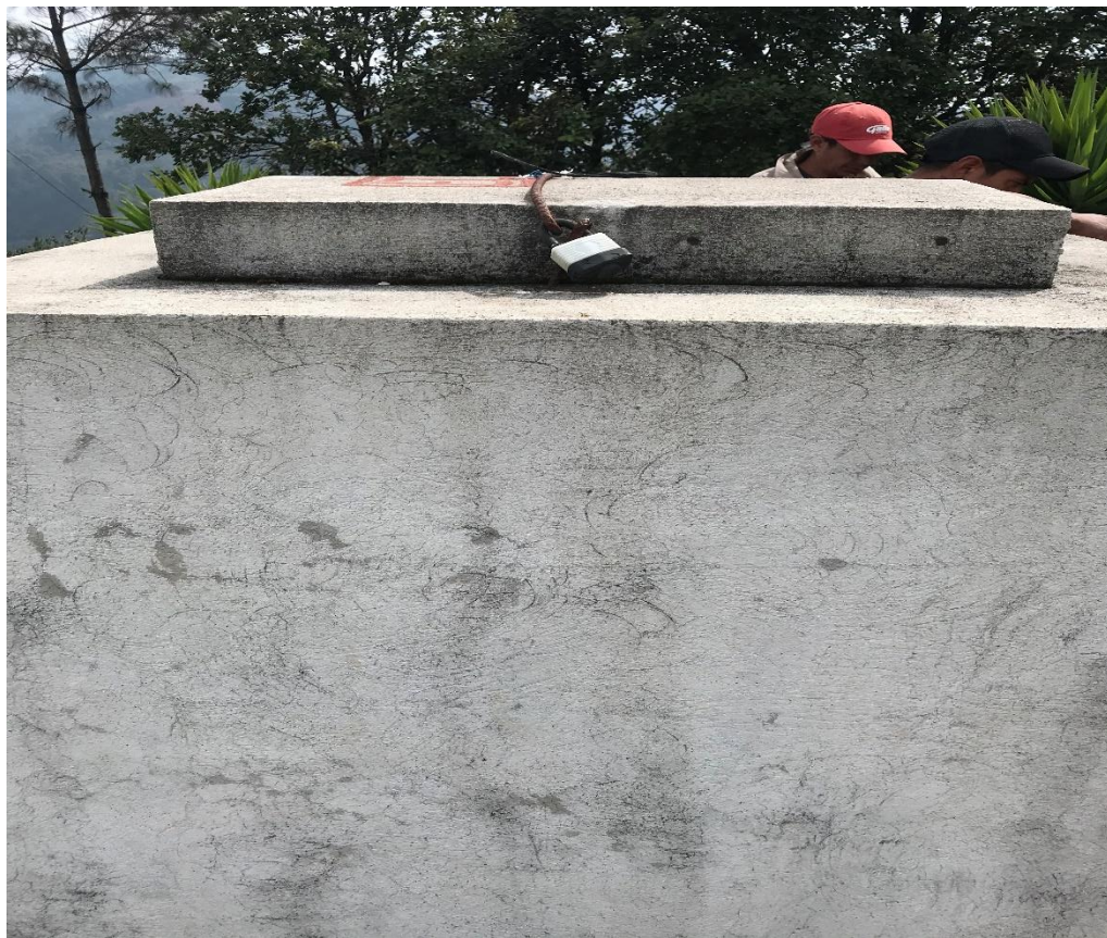
Ilustración 5. Se observa unidad de cloración en tanque de distribución, pero no está en operación por disposición de la comunidad.
