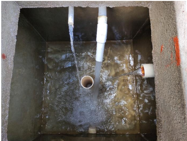
Ilustración 6: Fotografías de cajas reunidoras de caudales
