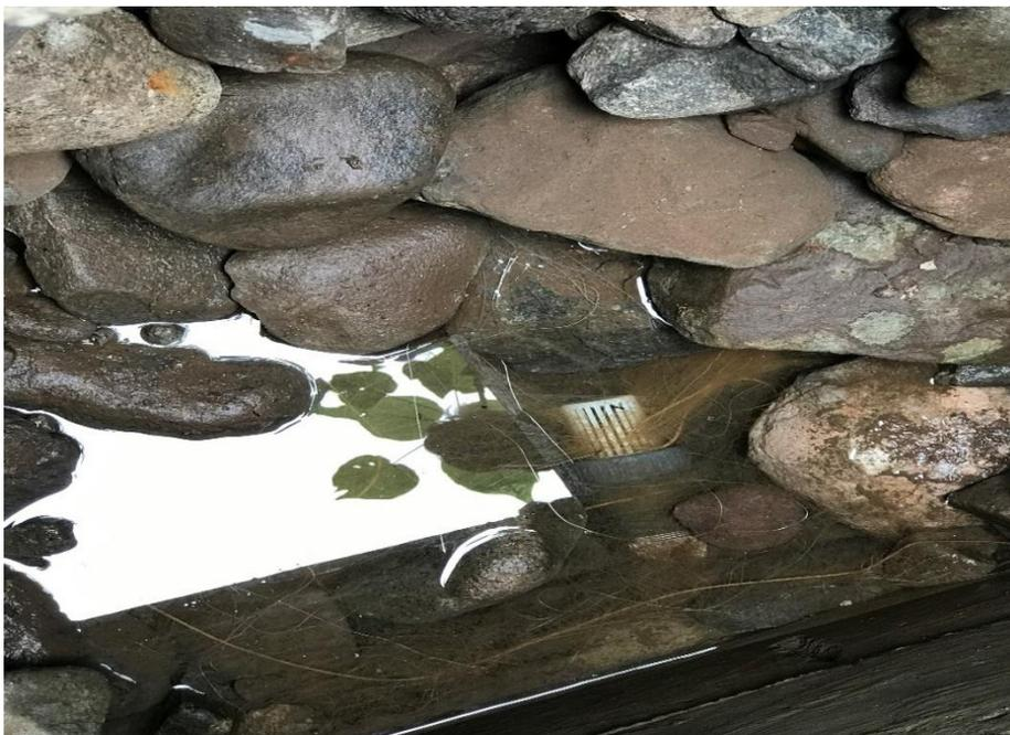
*Ilustración 4. Obra de arte para la captación de la fuente, requiere realizar limpieza general de interior, para evitar contaminación.*
