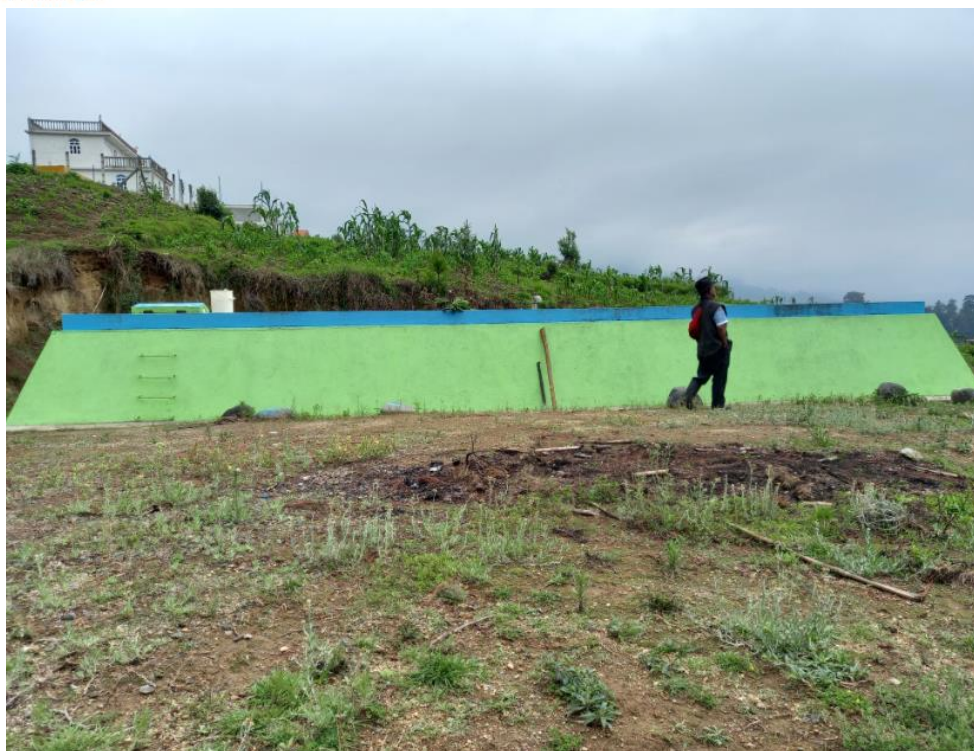
Fotografía 3. No existe espacio físico para sistema de desinfección. Elaboración propia.
