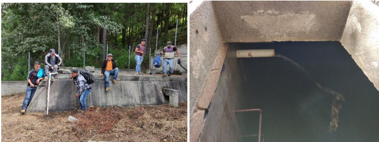
Ilustración 9: Fotografía de los tanques de distribución
