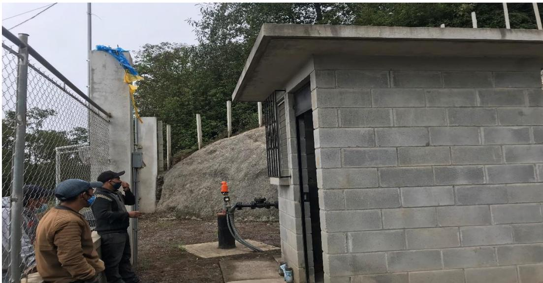
*Ilustración 3. Ubicación de bomba y caseta de bombeo, de pozo mecánico*
