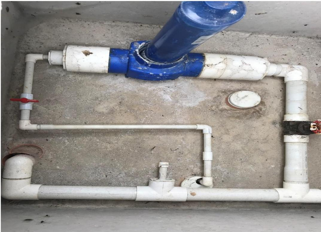
Ilustración 5. Se observa el conjunto de los elementos que constituyen la distribución de agua, el cual cuenta con unidad de cloración, pero no está en operación por disposición de la población.
