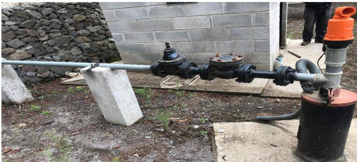
Ilustración 13. Componentes de sistema de bombeo.
