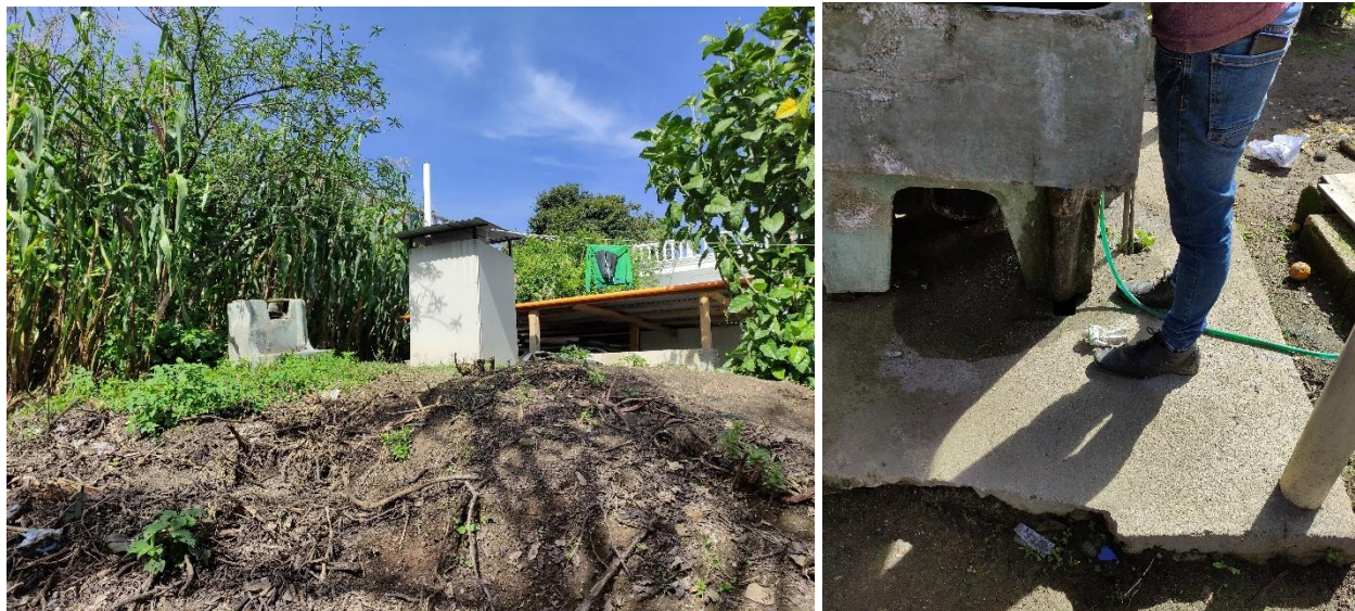
Ilustración 9: Fotografías del estado del saneamiento
