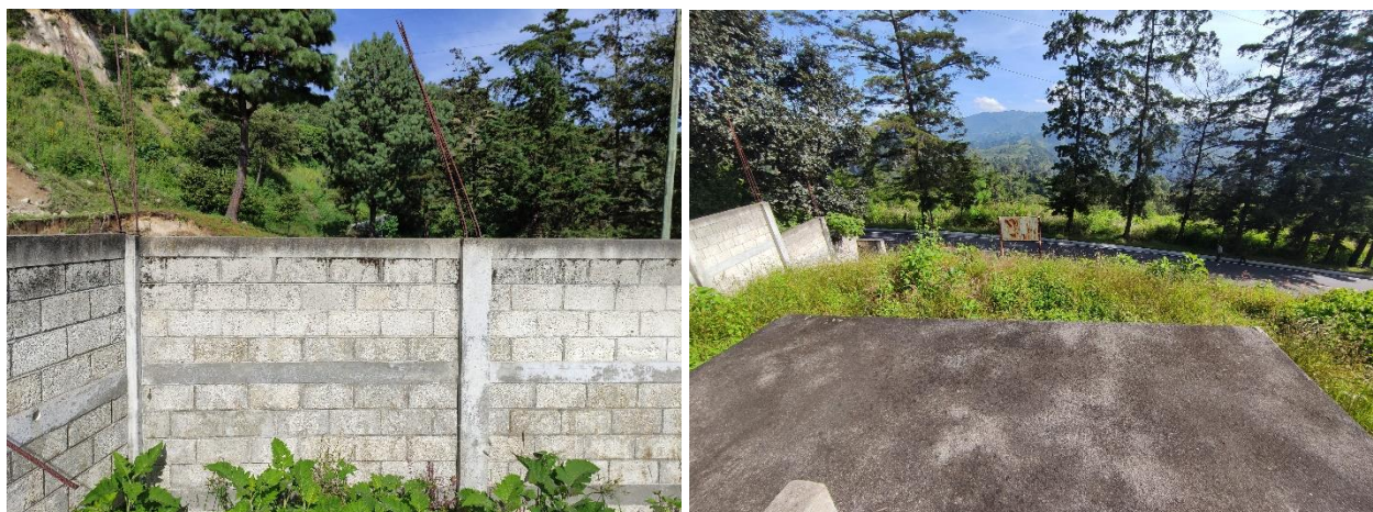
Ilustración 6: Fotografía del predio del tanque de distribución
