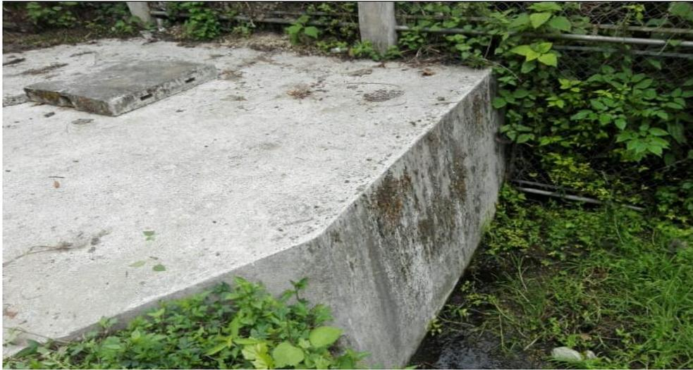
*Ilustración 3. Obra de arte para la captación de la fuente, requiere realizar limpieza general de alrededores*
