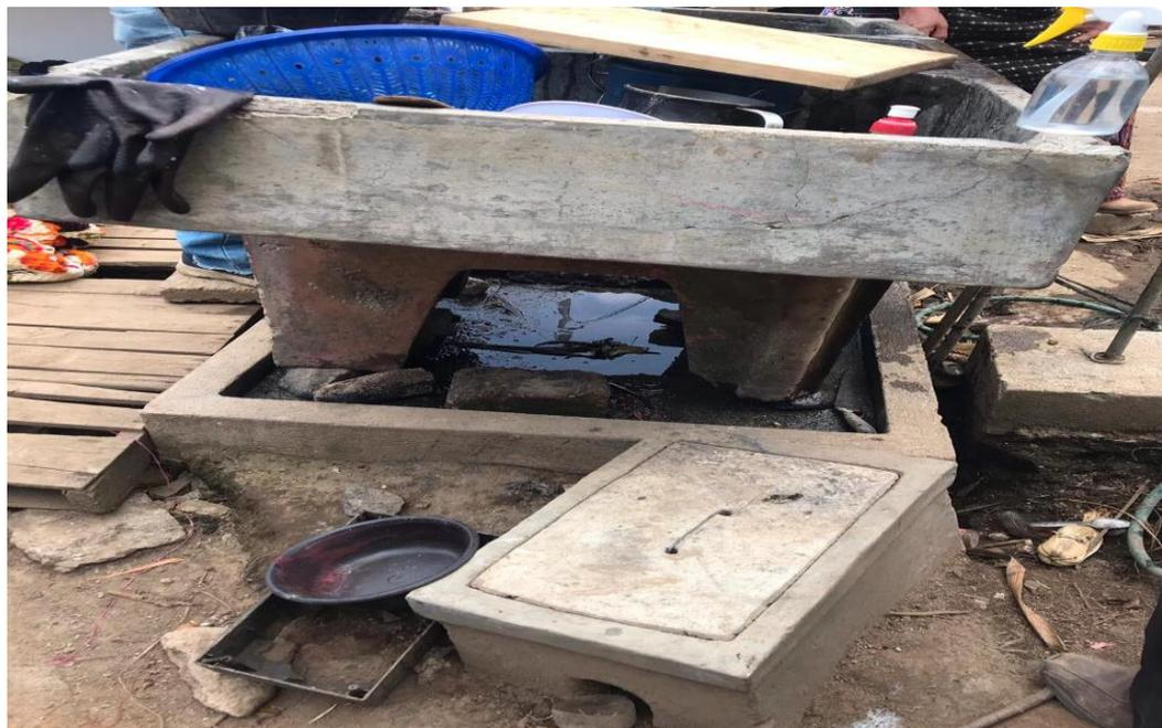
Ilustración 7. Representación de disposición final de aguas grises.
