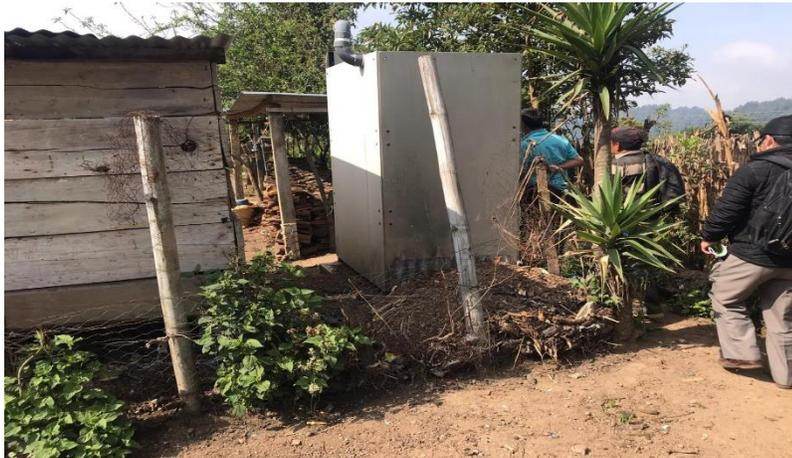
Ilustración 6. Se representa la disposición final de excretas, mediante letrinas de hoyo seco ventilado.
