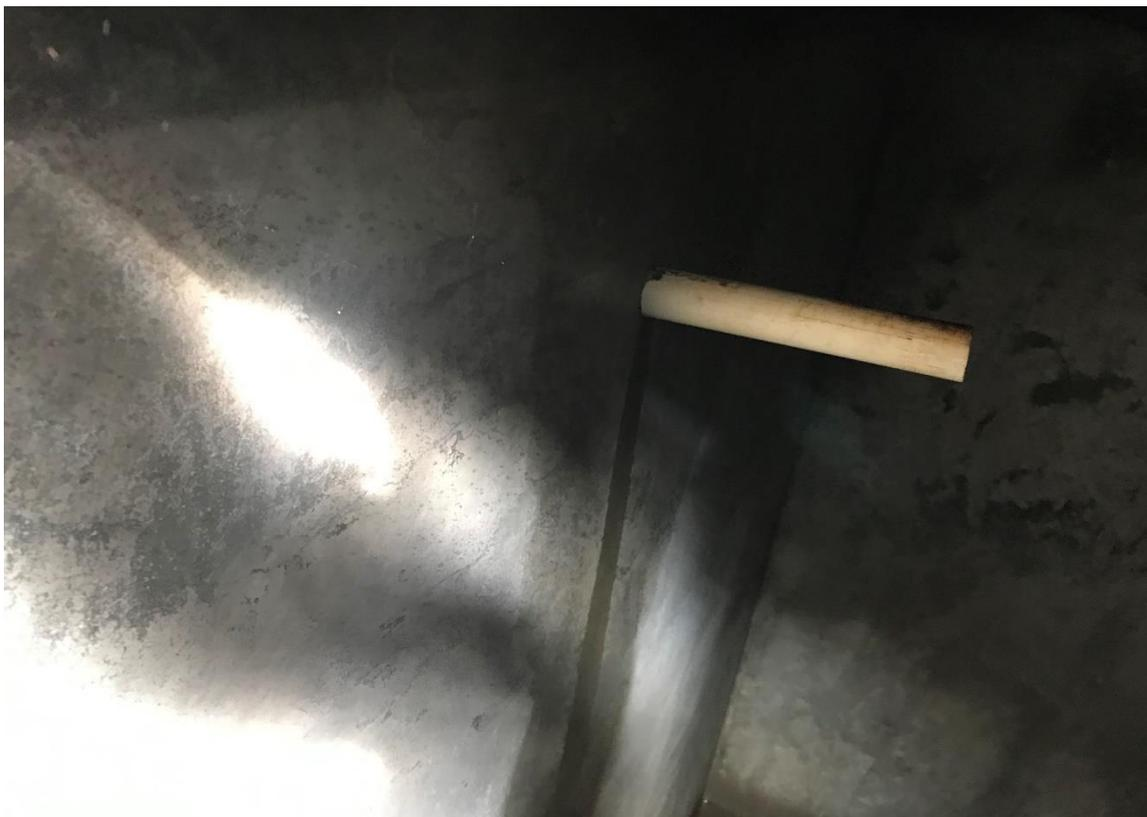
Ilustración 5. Se observa tubería de conducción sin previa cloración a tanque de distribución.
