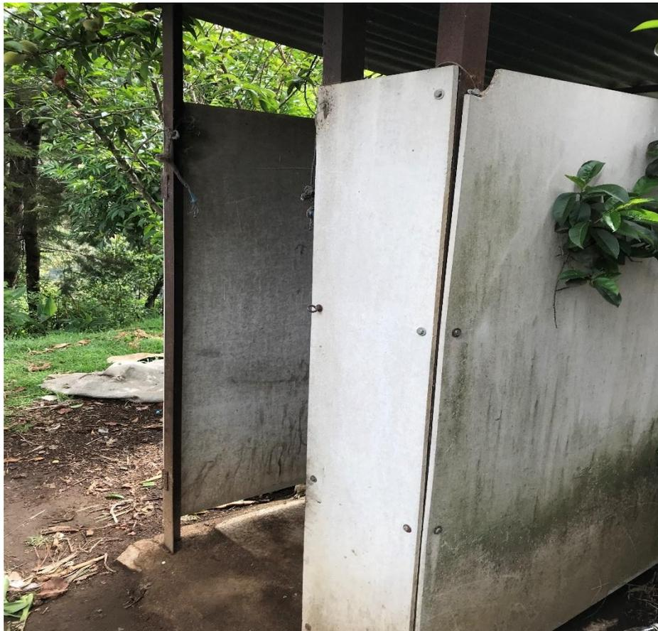
*Ilustración 6. Se Ilustración representa la disposición final de excretas, mediante letrinas de hoyo seco ventilado.*
