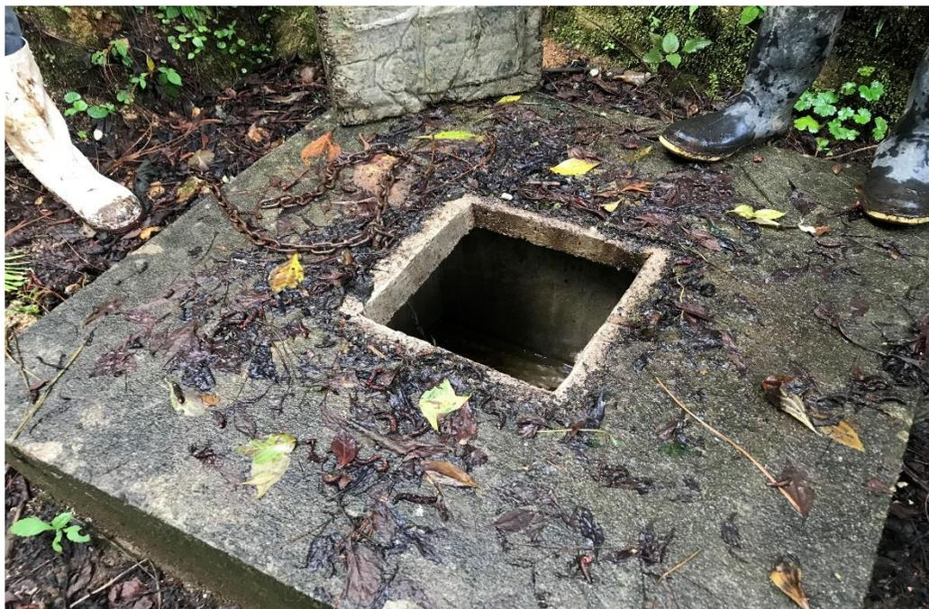
Ilustración 3. Obra de arte para la captación de la fuente, requiere realizar limpieza general de alrededores para evitar cualquier tipo de contaminación
