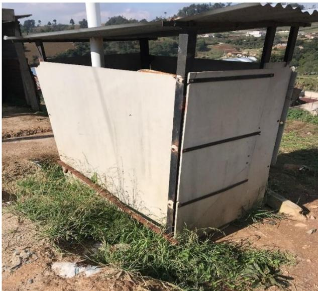
*Ilustración 6. Se representa la disposición final de excretas, mediante letrinas de hoyo seco ventilado.*
