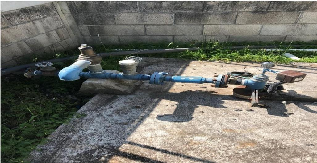
*Ilustración 10. Elementos del sistema de bombeo, ubicado en el tanque de almacenamiento.*
