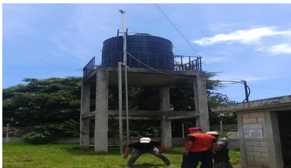
Ilustración 7: Vista del tanque de almacenamiento donde no existe sistema de desinfección
